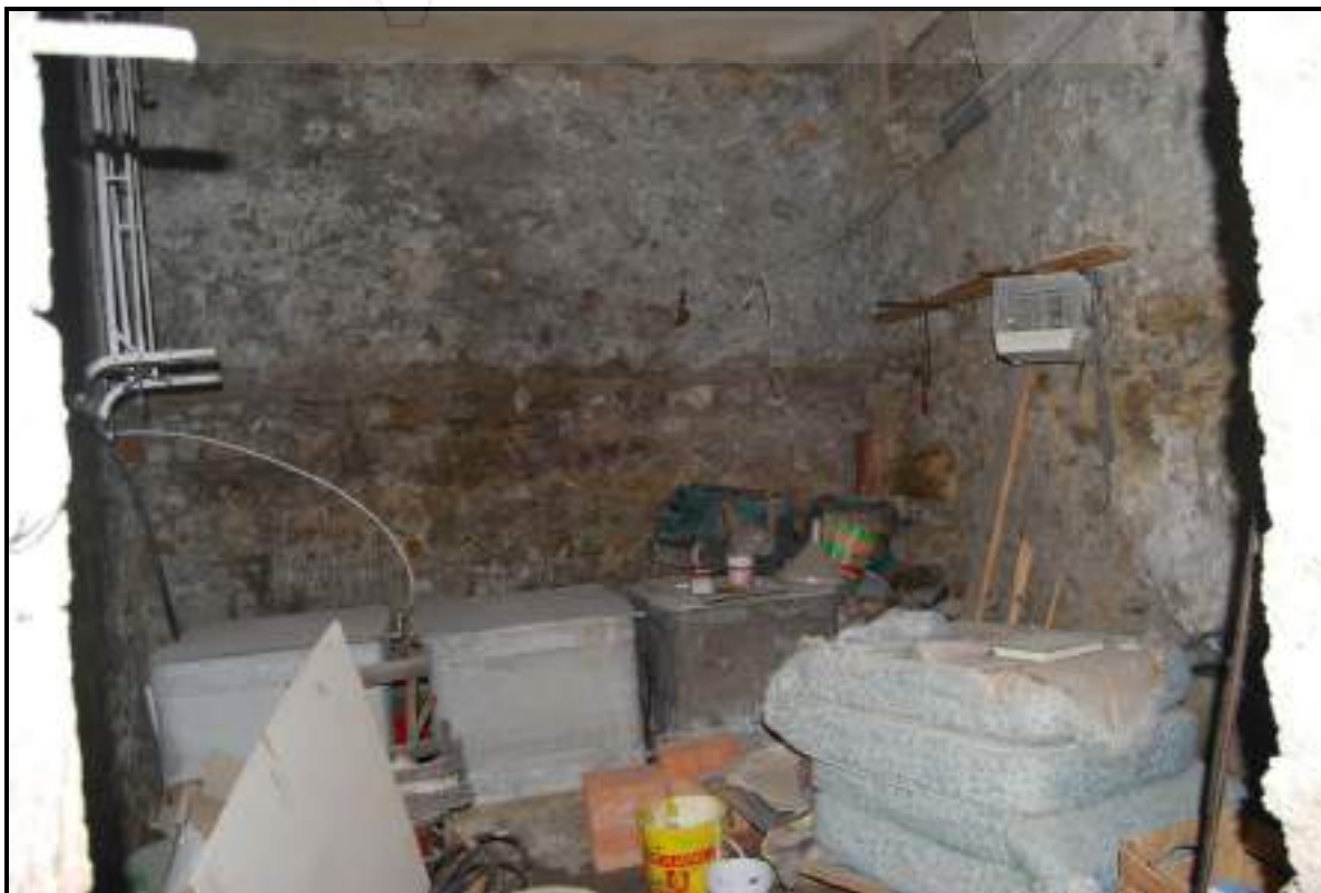
FOTO 73 – Nicosia - Foglio 82 – Particella 2669 – Sub. 1 – Piano terra – Locale di sgombero e deposito idrico
