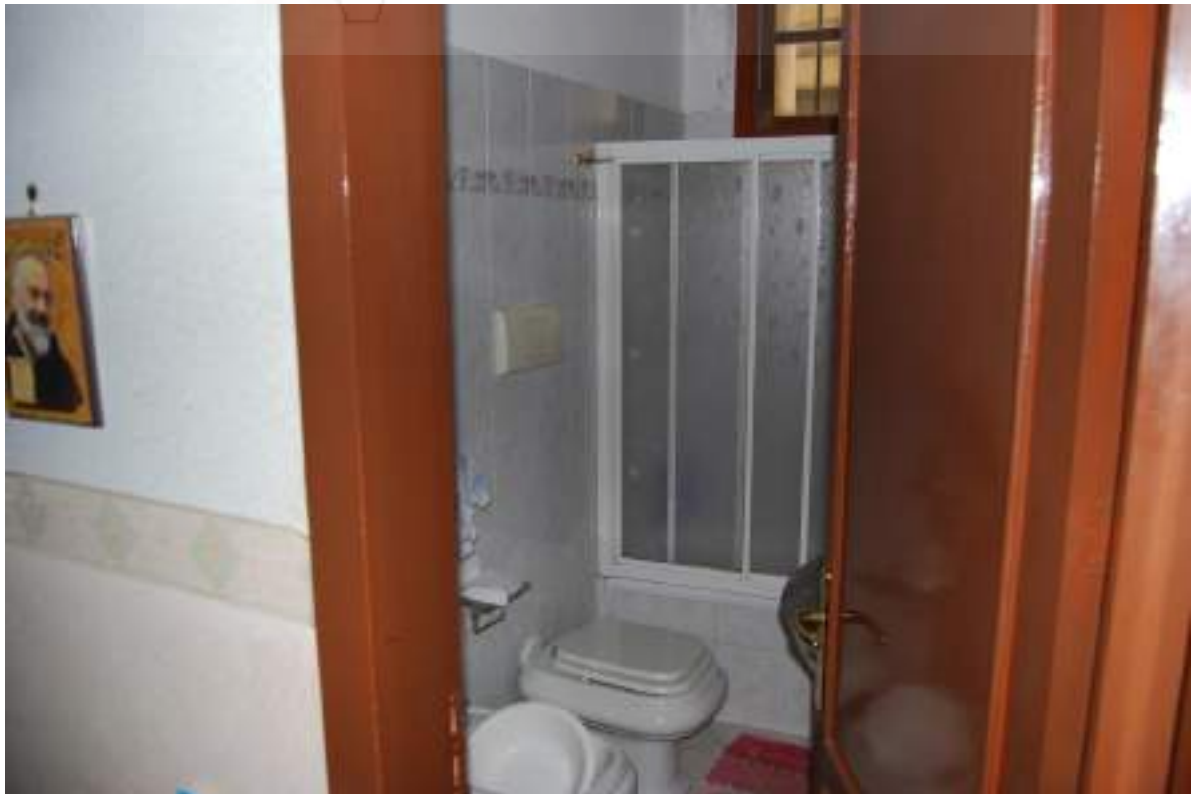
FOTO 11 – Nicosia - Foglio 82/L – Particella 2669 – Piano terra – Bagno
