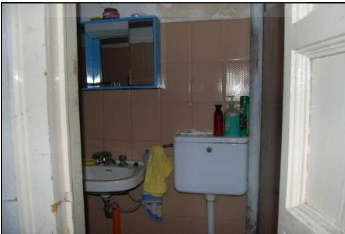
FOTO 77 – Nicosia - Foglio 82 – Particella 2669 – Sub. 2 – Piano primo – Servizio igienico
