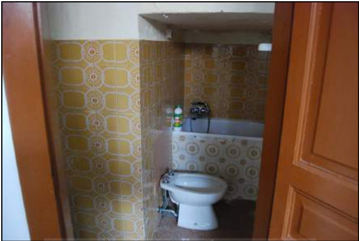
FOTO 27 – Nicosia - Foglio 82/I – Particelle 2467 – Sub. 1 – Piano seminterrato - Bagno realizzato nell'ex garage
