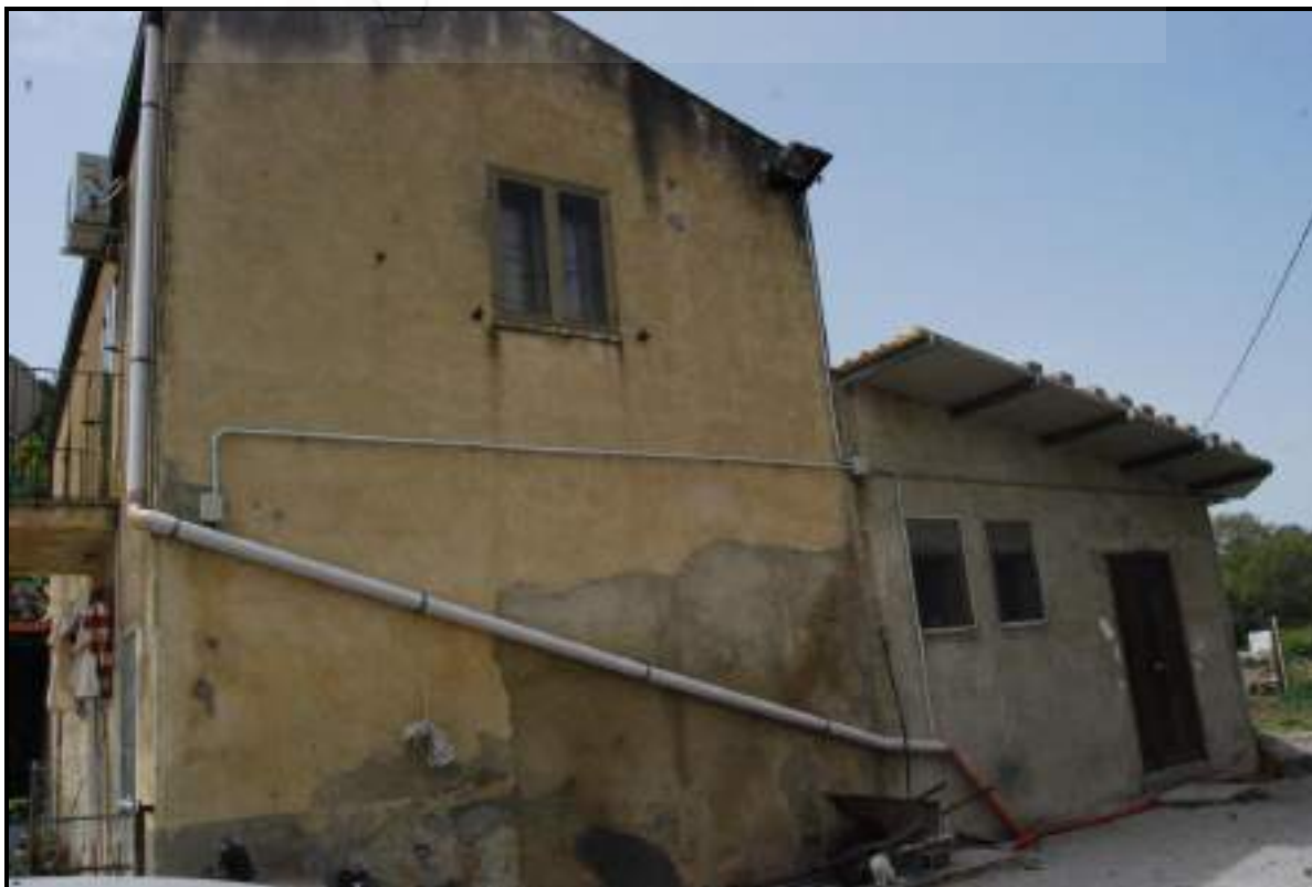
FOTO 38 – Nicosia - Foglio 68 – Particella 360 - Sub 1 e Sub 2 – Veduta Sud degli immobili di Contrada Scaletta
