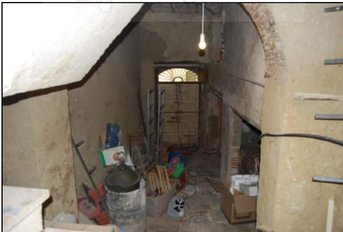
FOTO 5 – Nicosia – Foglio 82/L – Particella 2669 – Piano seminterrato – Ingresso secondario e locale di sgombro
