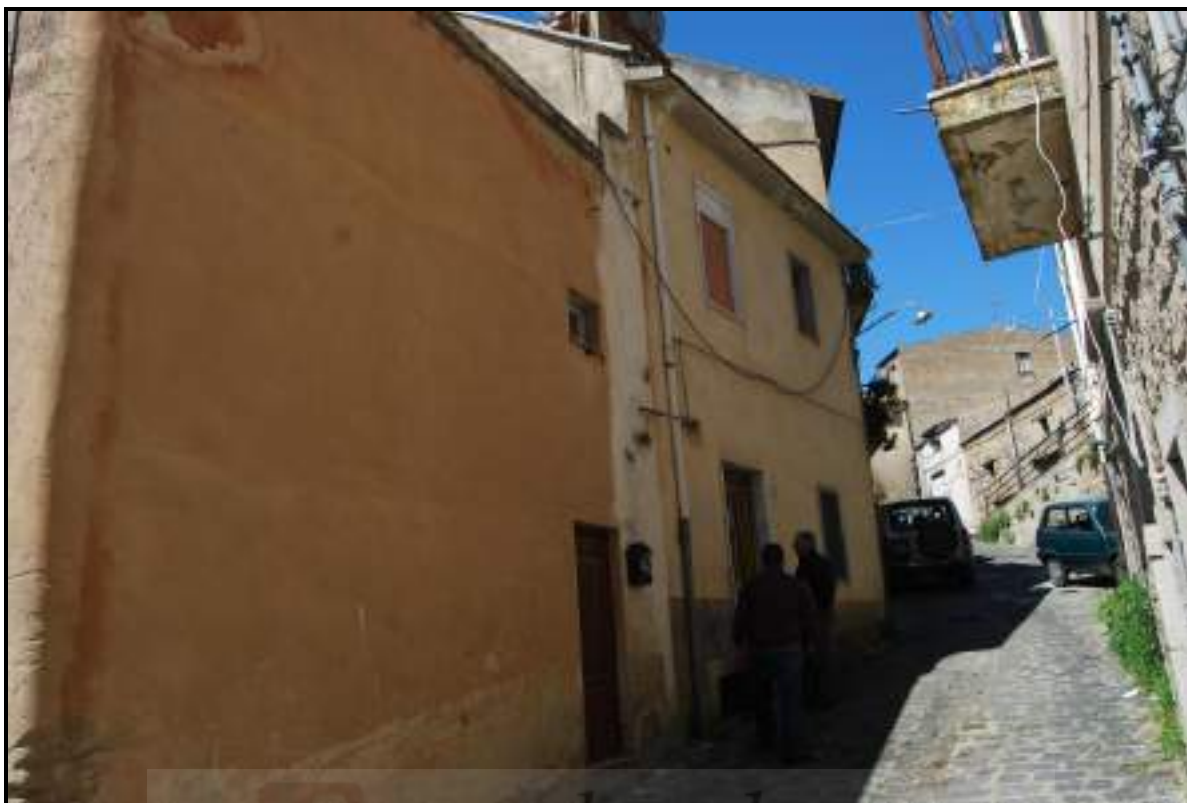
FOTO 23 – Nicosia - Foglio 82/I – Particelle 2466 e 2467 – Vedute dei fabbricati su Via Gaetano Giunta
