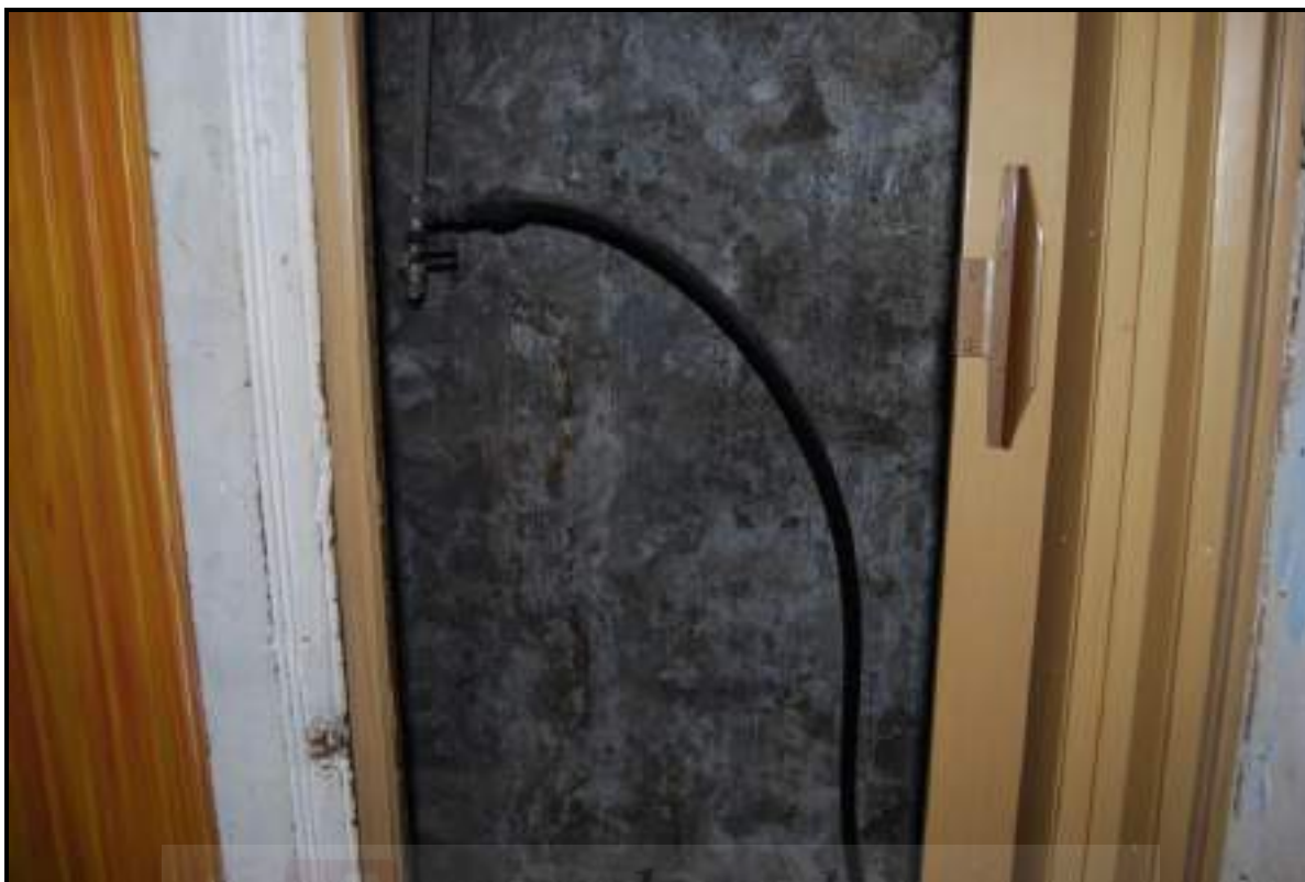
FOTO 74 – Nicosia - Foglio 82 – Particella 2669 – Sub. 2 – Piano terra – Ripostiglio
