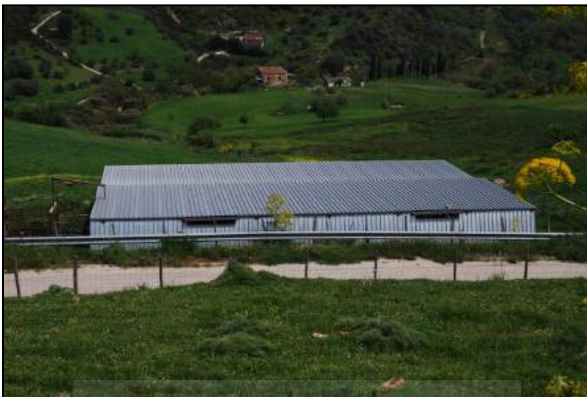
FOTO 61 – Nicosia - Foglio 68 – Particella 396 - Sub 1 – Veduta esterna dell'immobile mai dichiarato insistente sulla part. 270
