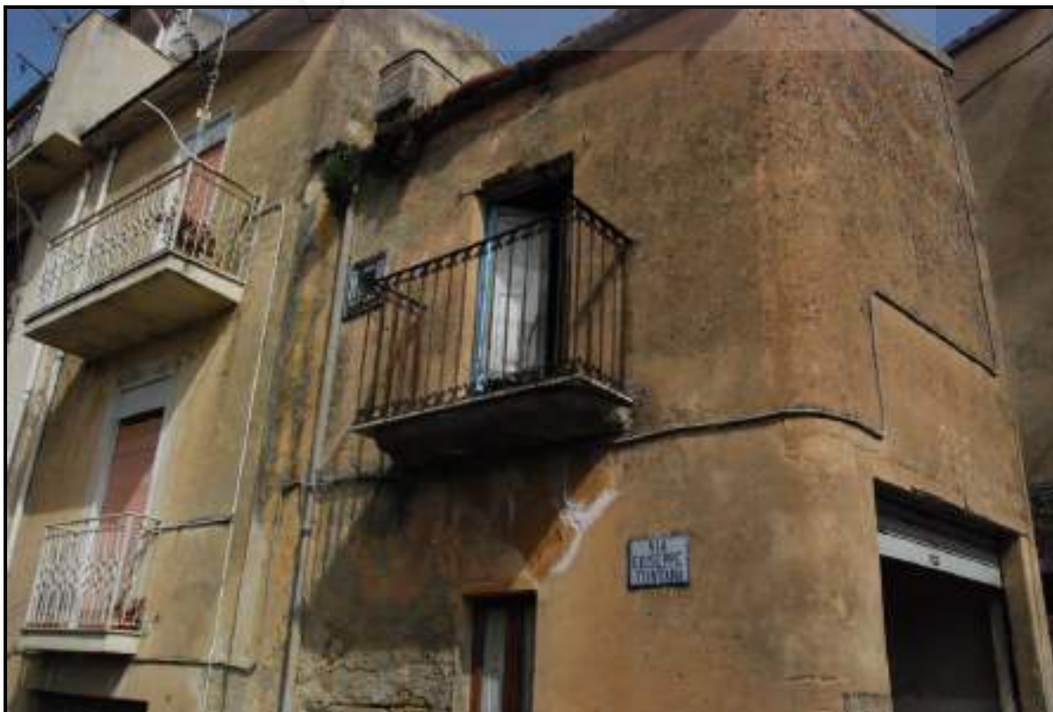
FOTO 24 – Nicosia - Foglio 82/I – Particelle 2466 – Sub. 2 - Veduta esterna del magazzino su Via Giuseppe Fontana
