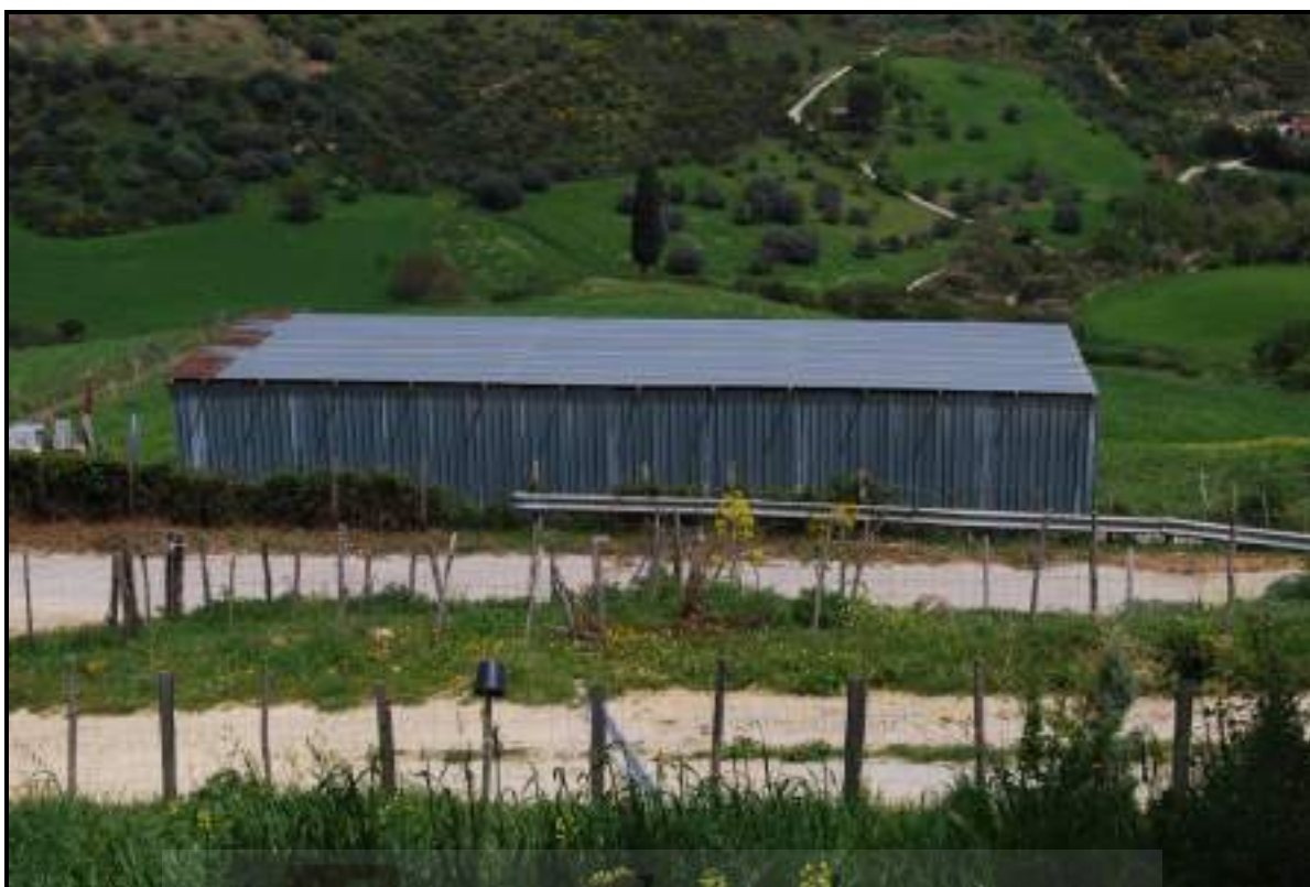
FOTO 63 – Nicosia - Foglio 68 – Particella 396 - Sub 2 – Veduta esterna dell'immobile mai dichiarato insistente sulla part. 270
