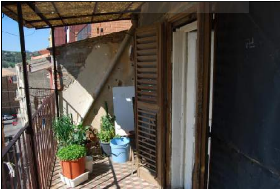
FOTO 81 – Nicosia - Foglio 82 – Particella 2669 – Sub. 2 – Piano secondo – Terrazzino esterno su Via Carlo V
