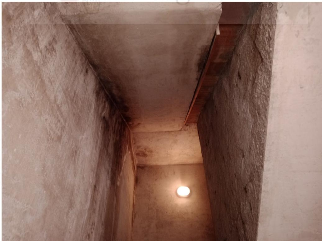
FOTO 10 – RAMPA DI SCALE AL PRIMO PIANO: ulteriori dettagli delle infiltrazioni di acqua
