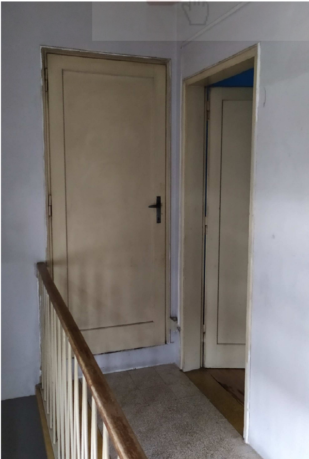
Ballatoio al piano primo
