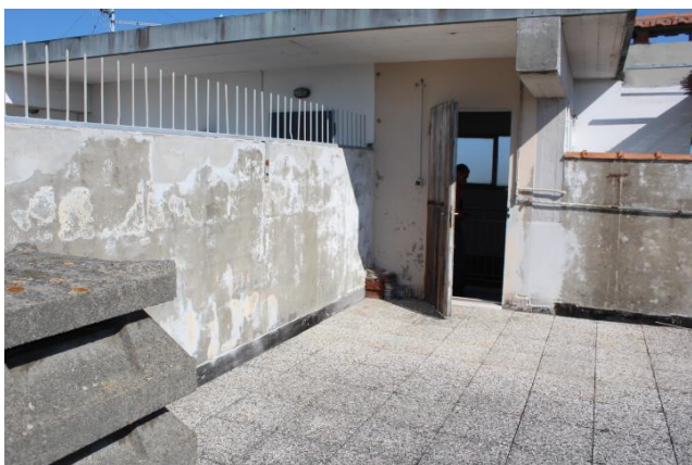
PARTICOLARE INGRESSO VISTO DAL TERRAZZO CON PENSILINA DI PROTEZIONE
