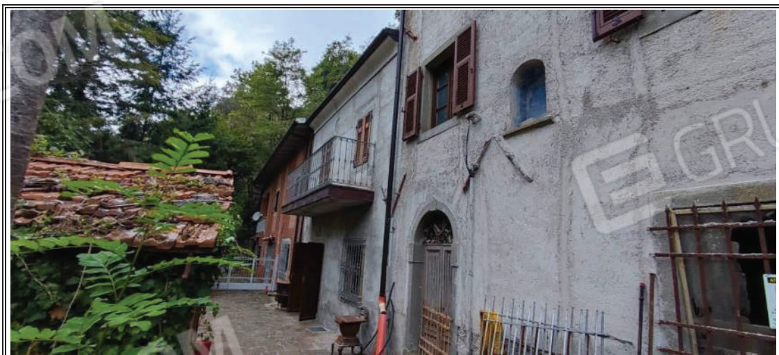
Foto n. 3 – Porzione di fabbricato oggetto di perizia
