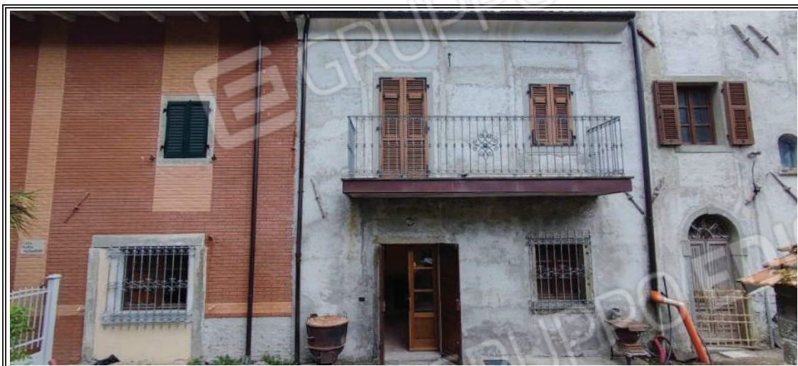
Foto n. 4 – Porzione di fabbricato oggetto di perizia
