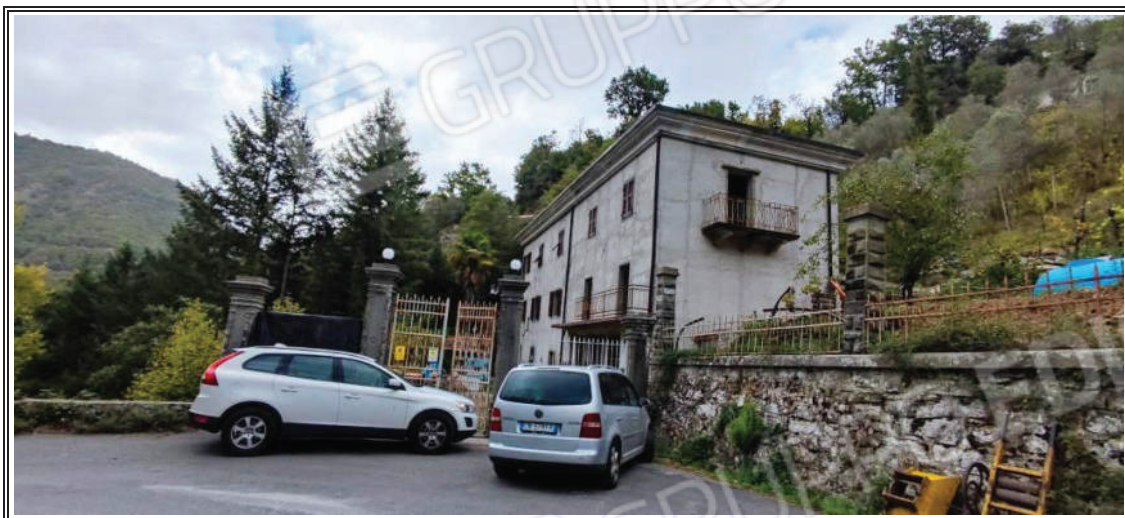
Foto n. 1 – Vista del fabbricato dalla strada Via Pognana
