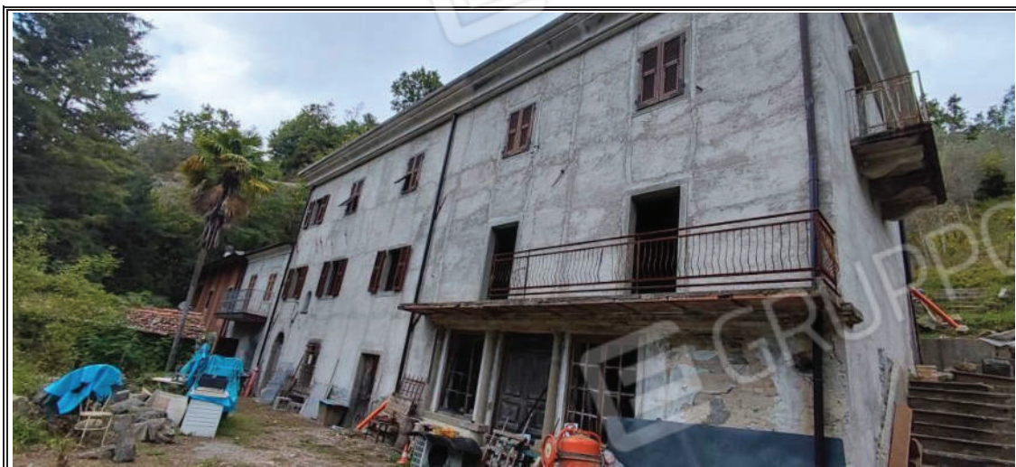
Foto n. 2 – Vista del fabbricato – Angolo SUD
