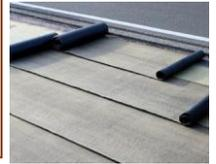
Il solaio di copertura, con isolante acustico e termico sarà finito con pavimento galleggiante in gres porcellanato
