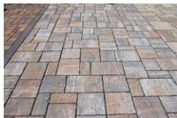
Vialetti pedonali realizzati con elementi cementizi autobloccanti marca Ferrari BK o equivalenti colorazione a discrezione della D.L. in sintonia con le disposizione della Sovrintendenza
