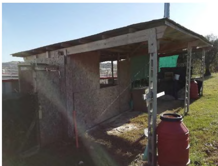
Tettoia (da demolire)
