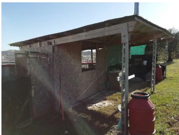
Tettoia (da demolire)
