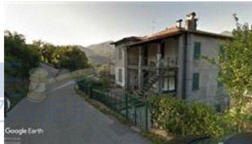
Vista esterna dei fronti nord est e nord ovest del fabbricato. La fotografia (fonte Google Earth) risulta non aggiornata, con particolare riferimento allo stato di manutenzione degli spazi esterni.
