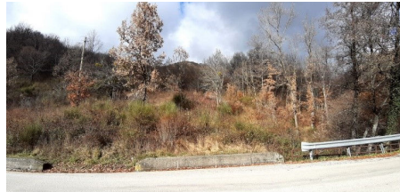
Foto n. 3 – Accesso dal fosso limitrofo al terreno
