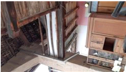
vista della copertura dal balcone del piano primo
