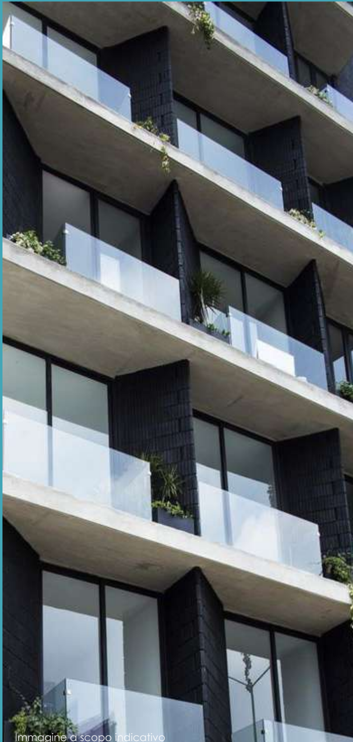
Pavimento Skema - Marina
