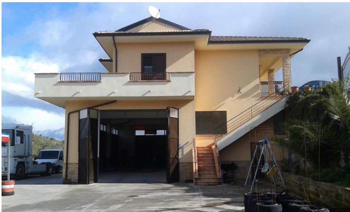
Foto n.2: abitazione a Nissoria, vista prospetto ovest
