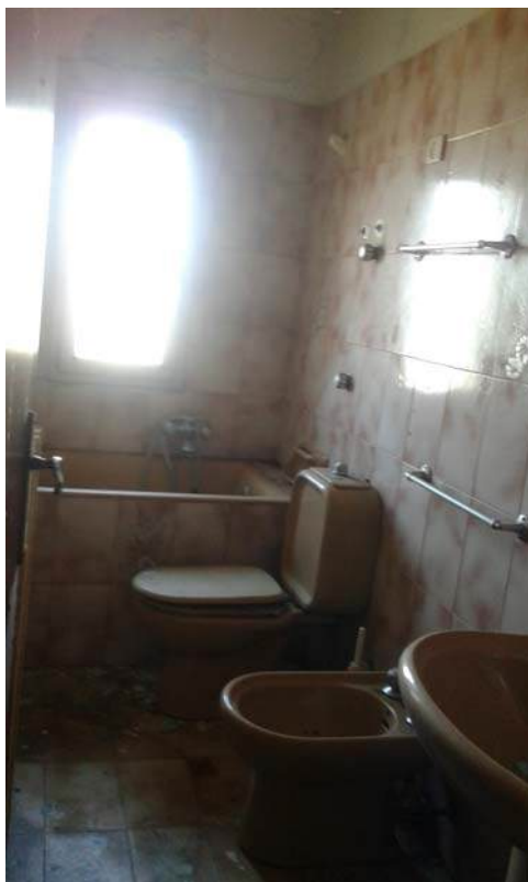
Foto n.28: abitazione ad Assoro, bagno al piano primo
