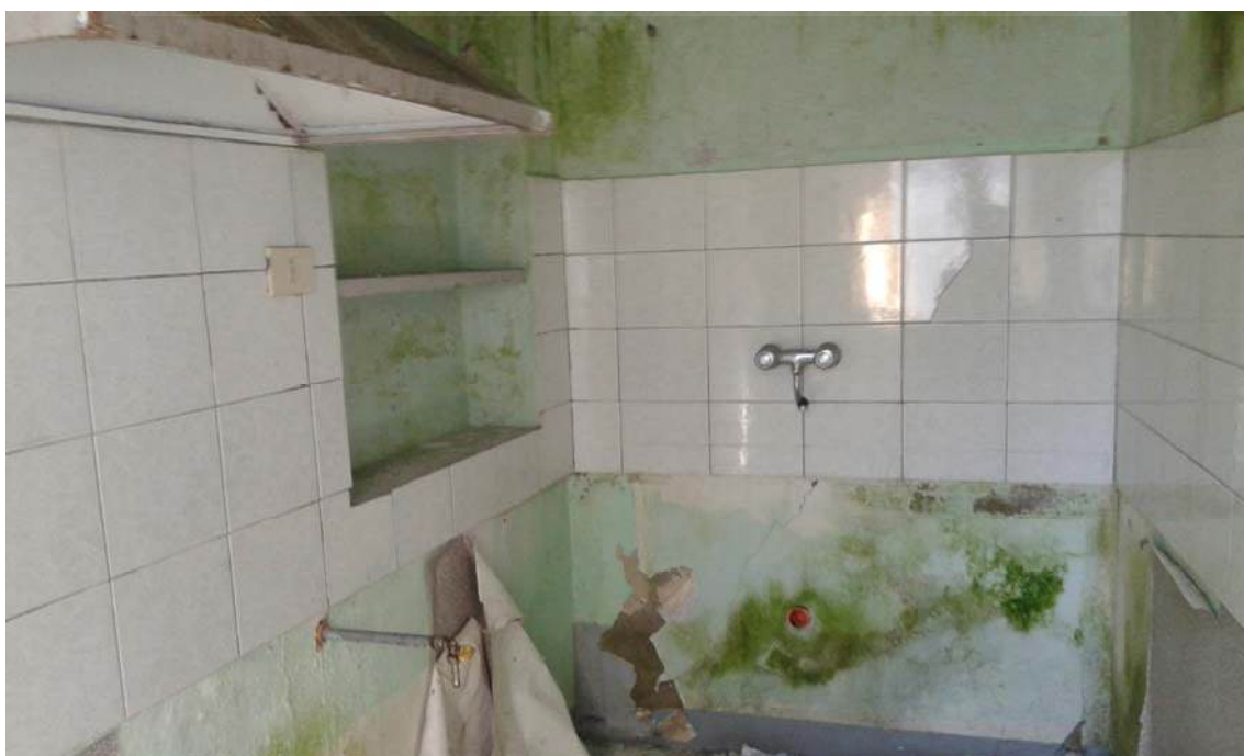
Foto n.25: abitazione ad Assoro, bagno piano terra
