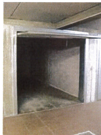
Vista interno autorimessa
