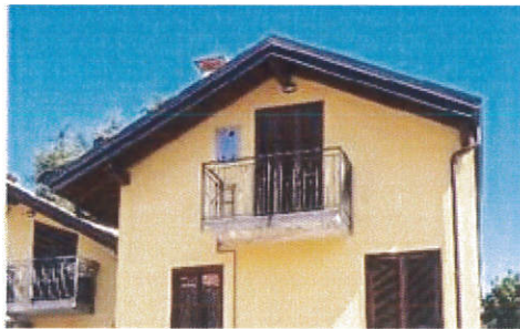
Vista Fronte Sud
