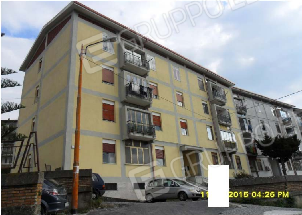
Foto 7. Vista esterna del fabbricato
