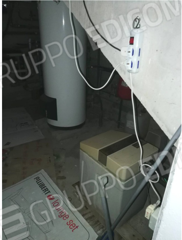
Foto 46-47. PS1: vano tecnico con accumulo e componentistica impianto solare termico ACS
