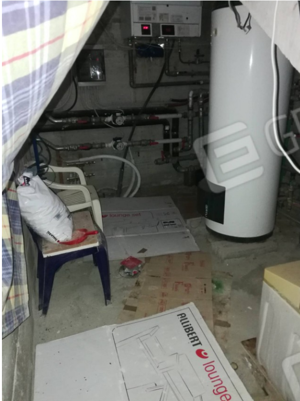
Foto 46-47. PS1: vano tecnico con accumulo e componentistica impianto solare termico ACS
