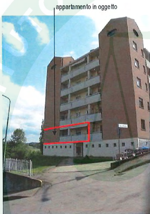
accesso carrabile e pedonale su Via Ugo La Malfa 5
