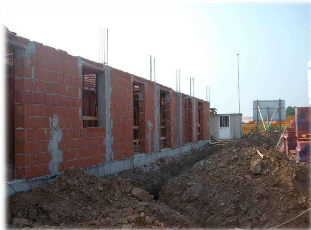
STRUTTURA PORTANTE "MISTA"
