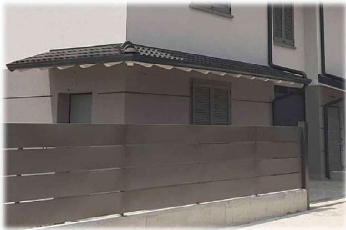
RECINZIONE ESTERNA FRONTE VIA PUBBLICA E CORSELLO DI MANOVARA
