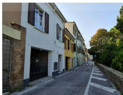
D - FACCIATA SU VIA MURA COMANDINI
