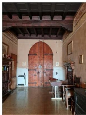
FOTO 17 - INGRESSO VISTA DEL PORTONE
