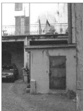
FOTO STORICA - CENTRALE TERMICA
