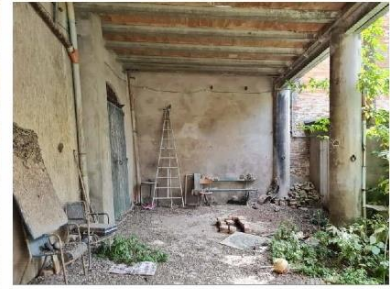
FOTO 35 - PIANO INTERRATO PORTICO
