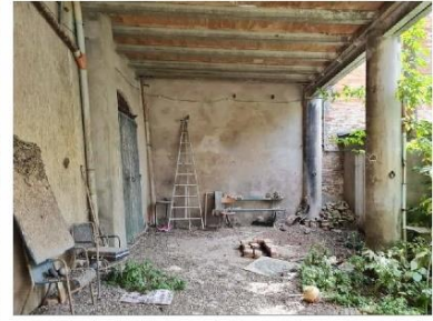
FOTO 35 - PIANO INTERRATO PORTICO
