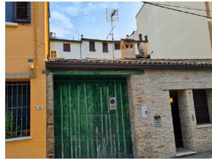
B - Passo Carraio via Mura Comandini FACCIATA SU VIA MURA COMANDINI
