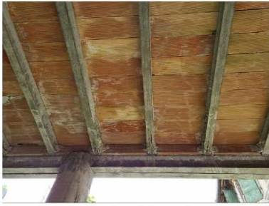
FOTO 33 - PIANO INTERRATO COPERTURA PORTICO
