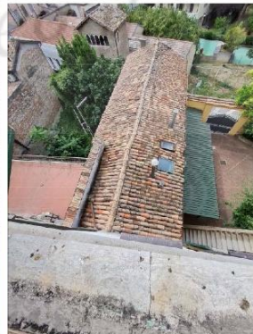
FOTO 13 - VISTA DALL'ALTO FABBR. SERVIZI
