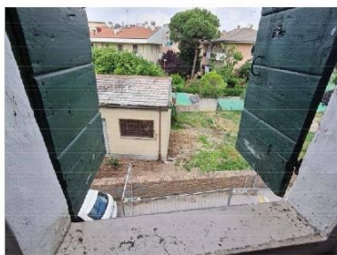
FOTO 89 - SCURONI FINESTRE FABBRICATO A SERVIZI
