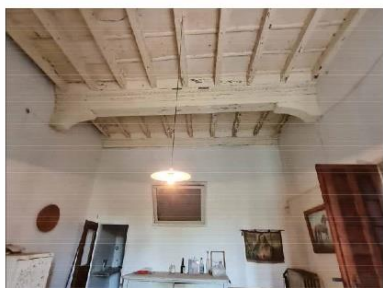
FOTO 88 - PIANO TERRA SOFFITTO VANO PRANZO
