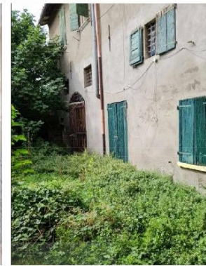
FOTO 32 - PIANO INTERRATO ALA A SERVIZI
