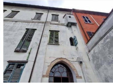
FOTO 3 - VISTA DA VIA MURA FEDERICO COMANDINI
