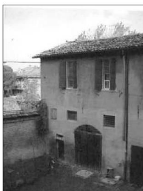
FOTO STORICA - ALA A SERVIZI
