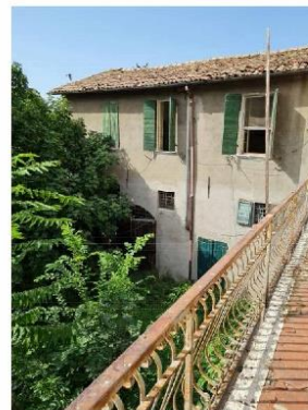
FOTO 7 - VISTA DEL FABBRICATO A SERVIZI
