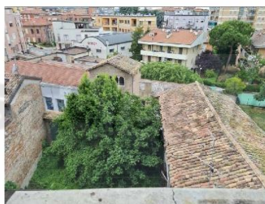
FOTO 9 - VISTA DALL'ALTO DEL CORTILE INTERNO
