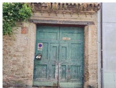
FOTO 90 - PORTONE DI ACCESSO SU VIA MURA FEDERICO COMANDINI
