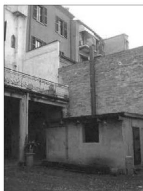
FOTO STORICA - CENTRALE TERMICA
