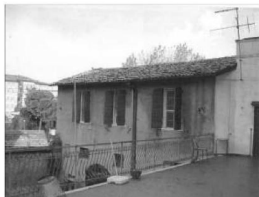
FOTO STORICA - ALA A SERVIZI
