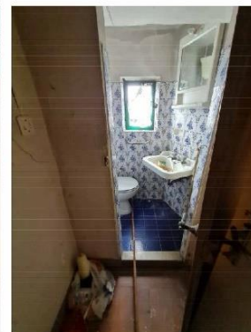
FOTO 87 - SECONDO PIANO BAGNO ESTERNO
