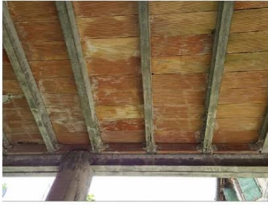
FOTO 33 - PIANO INTERRATO COPERTURA PORTICO
