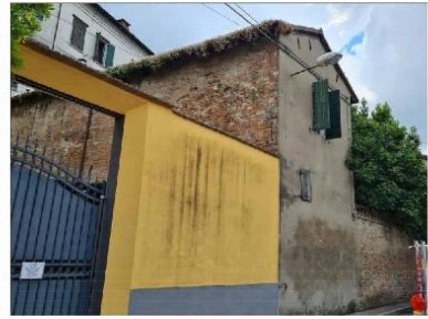
FOTO 10 - FABBRICATO A SERVIZI DA VIA MURA FEDERICO COMANDINI
