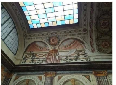
FOTO 28 - COPERTURA VANO SCALA
