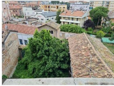
FOTO 9 - VISTA DALL'ALTO DEL CORTILE INTERNO
