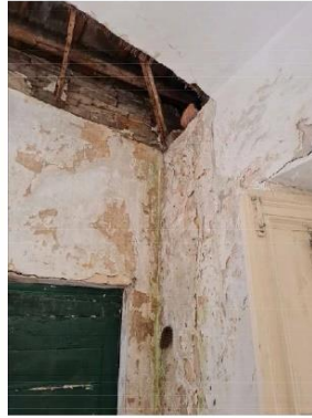
FOTO 69 - DEGRADO STRUTTURALE
