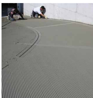
D1 - d _ Rampa corsello
