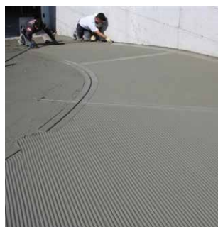
D1 - d _ Rampa corsello
