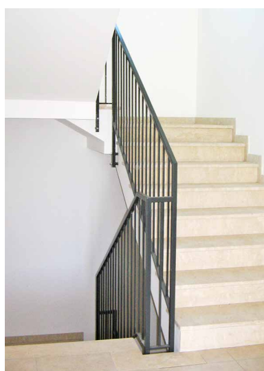
F _ Scala interna
