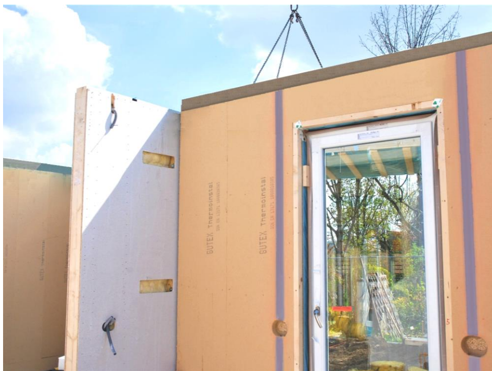
Predisposizione impianto elettrico su parete esterna ed interna
