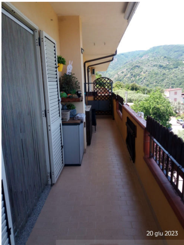
Foto 5 - P.S. Balcone Prospetto Ingresso
