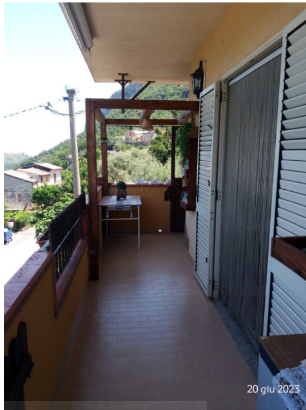
Foto 6 - P.S. Balcone Prospetto Ingresso
