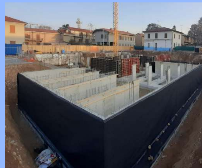
Figura 10 – Impermeabilizzazioni eseguite in altro cantiere
