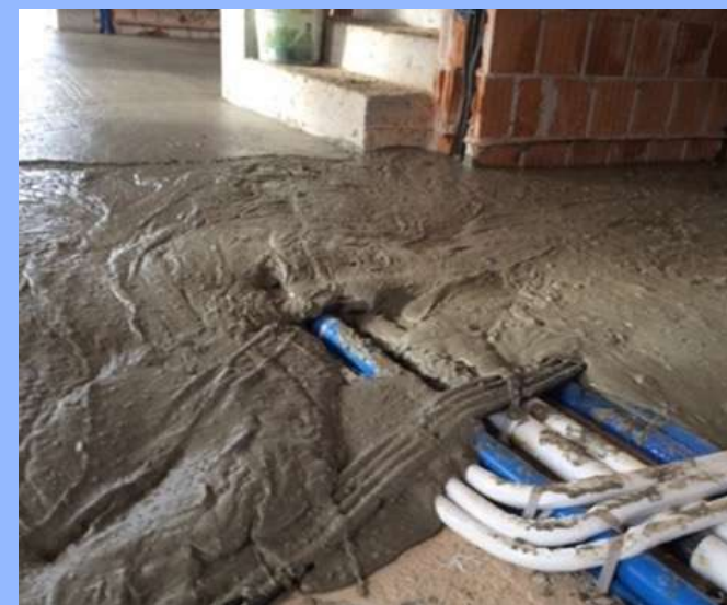
Figura 22 – Sottofondo alleggerito
