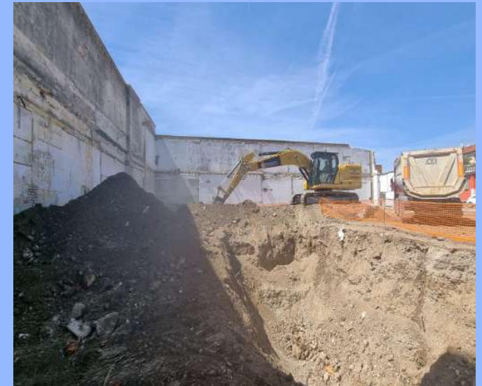
Figura 5 – Scavi eseguiti in altro cantiere
