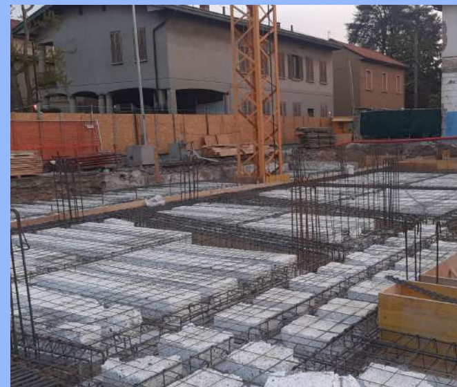
Figura 8 – Solaio predalles realizzato in altro cantiere
