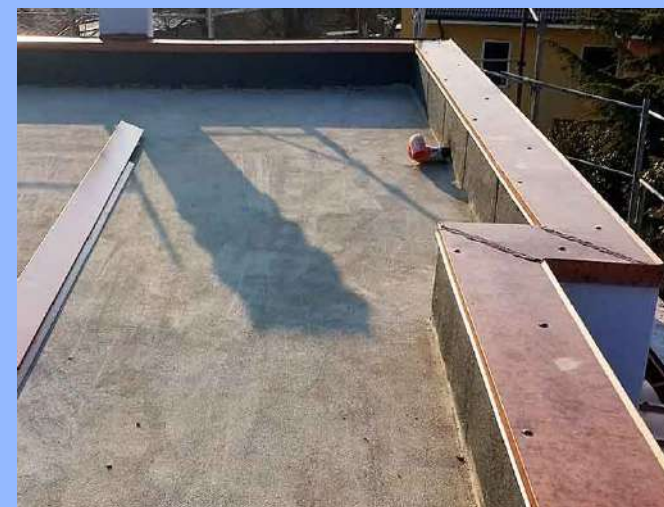
Figura 17 – Cappello in lattoneria coronamento copertura
