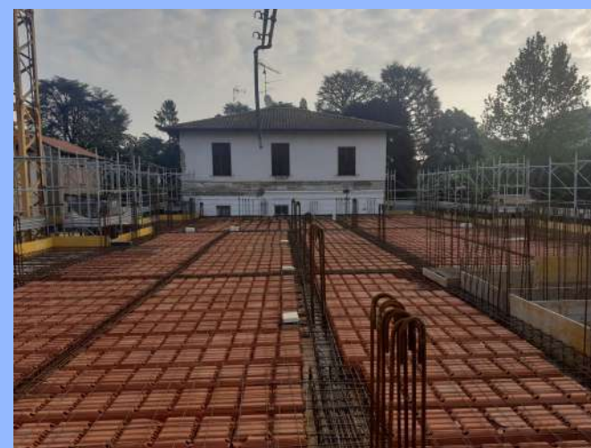
Figura 9 – Solaio laterocemento realizzato in altro cantiere
