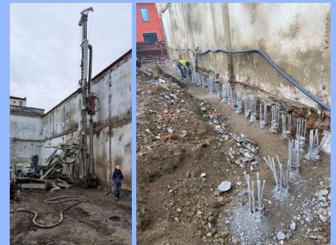
Figura 4 – Realizzazione berlinese in altro cantiere
