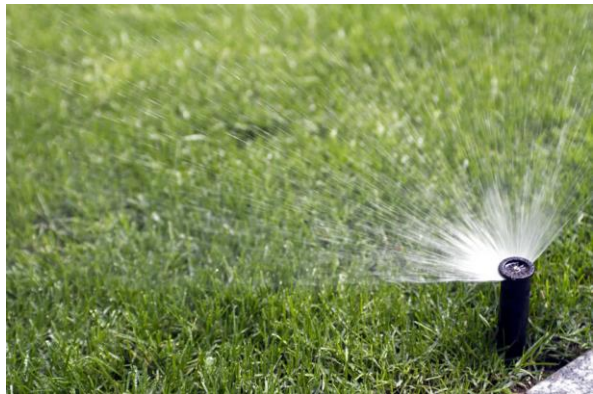
1 Impianto di irrigazione del verde condominiale
