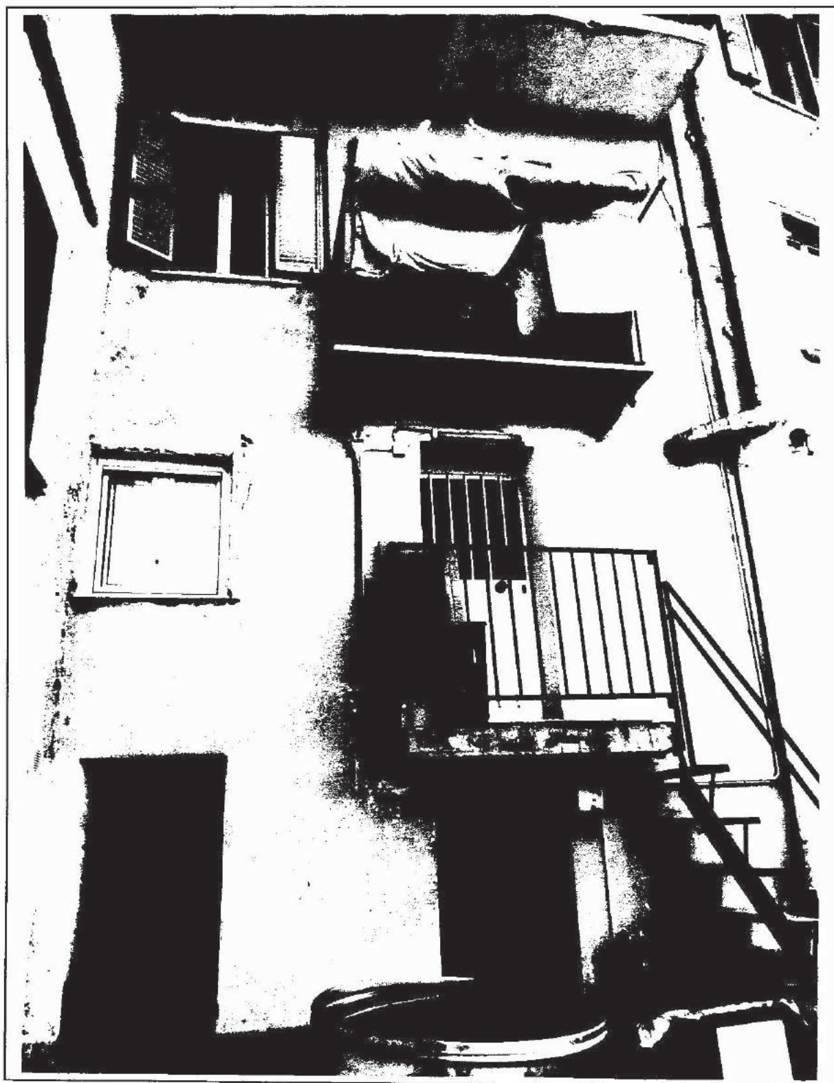
VISTA ESTERNA 4: Accesso da Via Trieste; vista prospetto lato inferiore del fabbricato.
