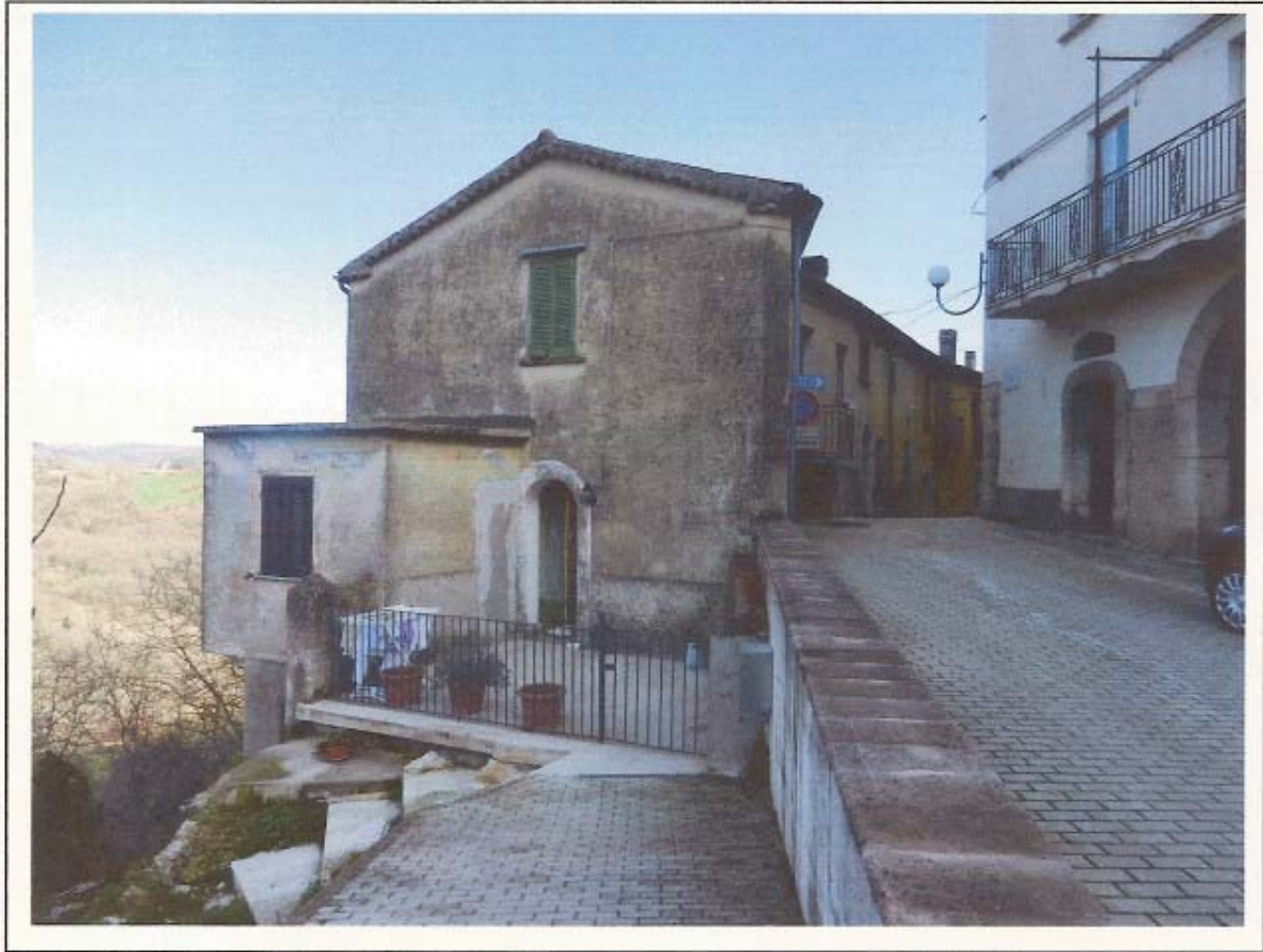
VISTA ESTERNA 1: Accesso da Via Trieste; accesso principale al fabbricato.
