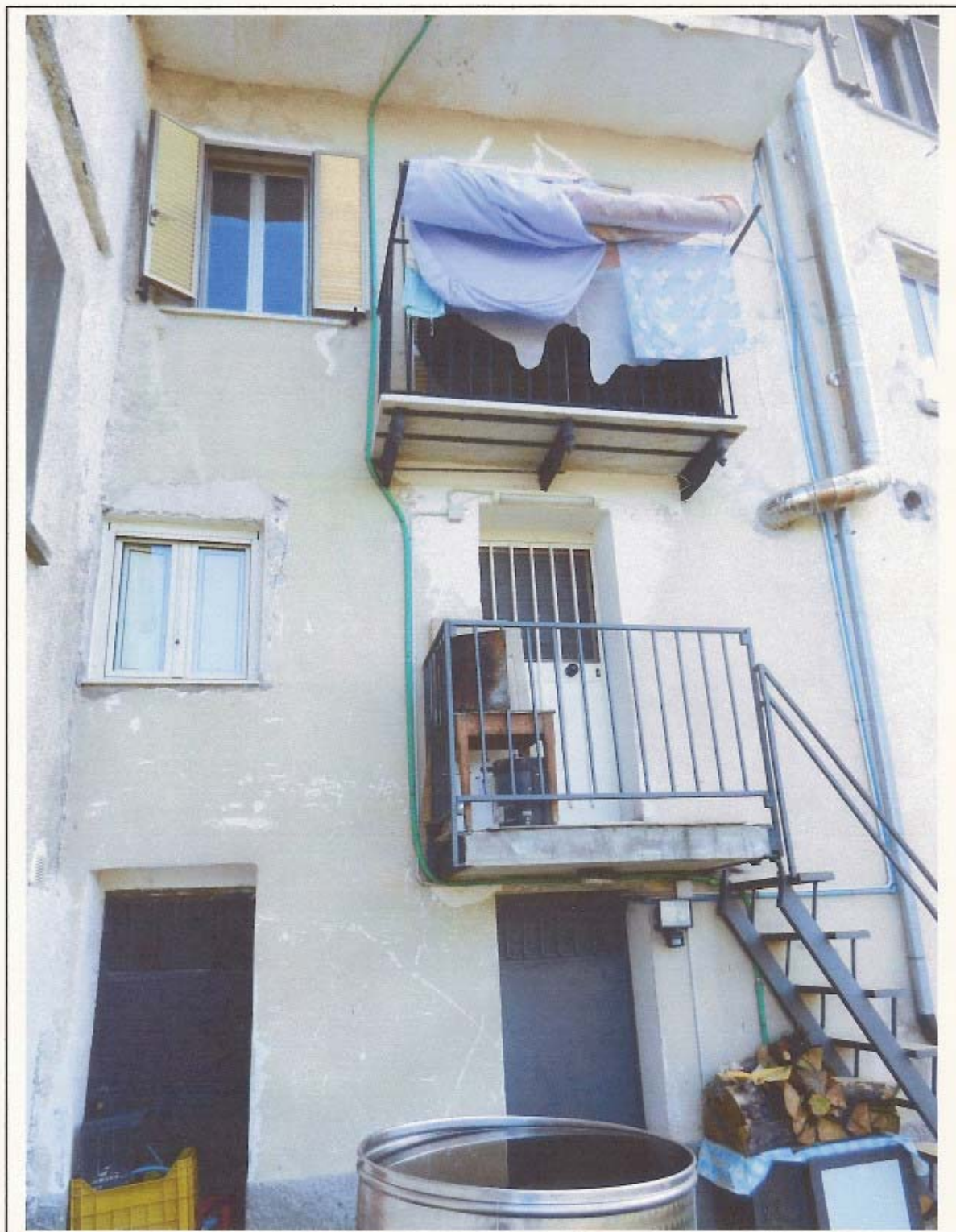
VISTA ESTERNA 4: Accesso da Via Trieste; vista prospetto lato inferiore del fabbricato.
