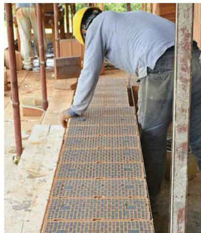
in malta di classe M10. Trasmittanza inferiore a 0,29 W/mqK come da DM 26/06/2015 Requisiti minimi.
