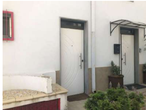
Accesso gradinata in calcestruzzo
