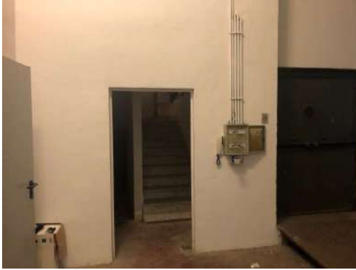
Gradinata interna e montacarichi
