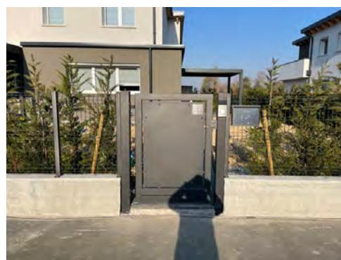
Ove necessarie saranno realizzate delle piantane in ferro zincato e verniciato dell'altezza di circa cm. 120 per il sostegno dei cancelli pedonali dotati di elettroserratura, e dei cancelli carrai motorizzati
