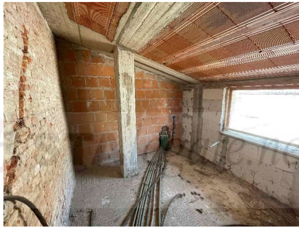
F10: Camera lato ovest – p. 1°
