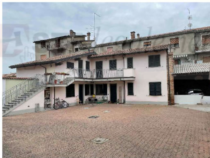
F3: Corte comune (part. 869), vista dall'ingresso comune
