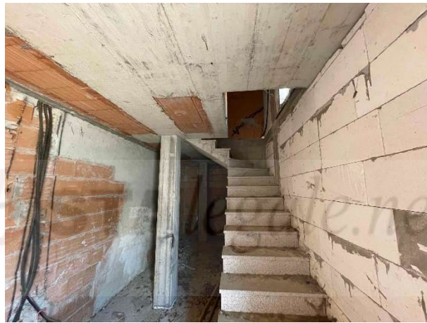
F7: Scala interna di collegamento al piano 1°
