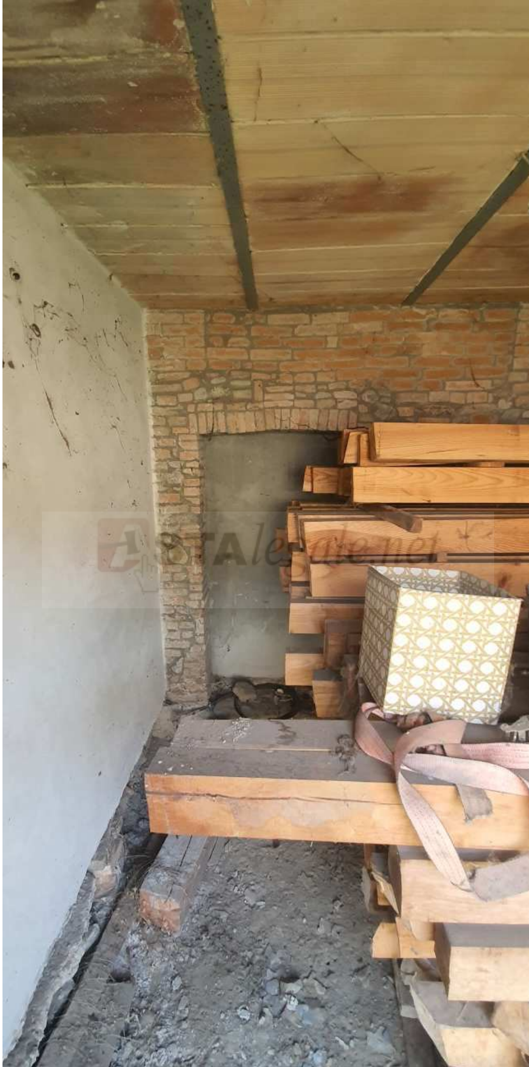
PARTICOLARE LOCALE LATO NORD-EST - PIANO TERRA
