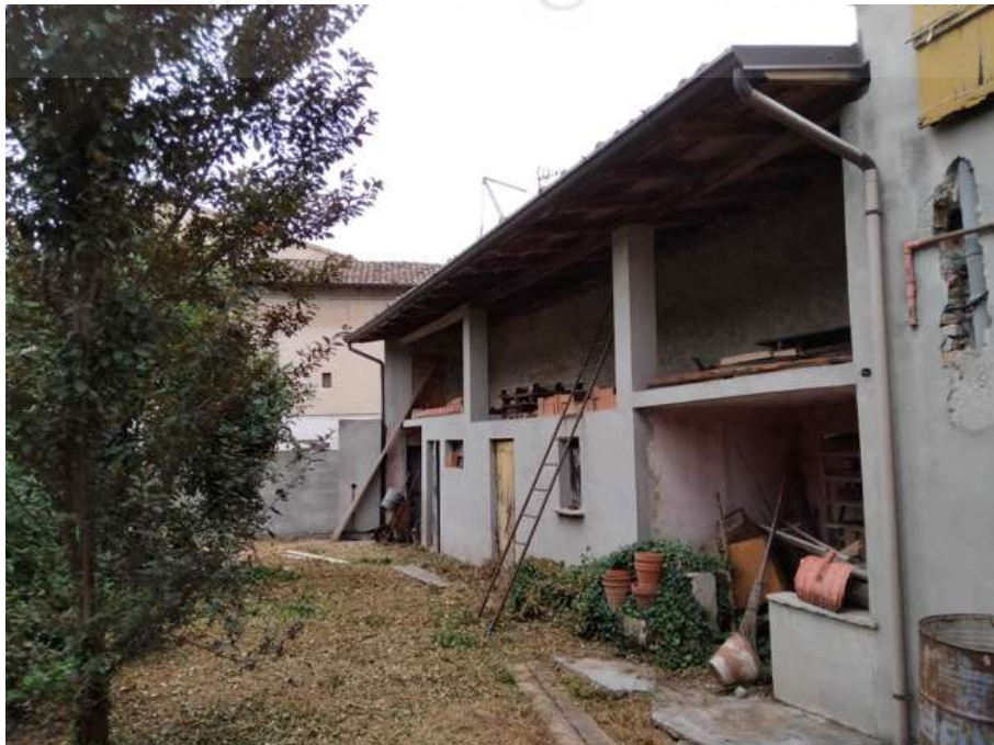
F18: Fabb.to di servizio sulla part. 749 (lato stradello)
