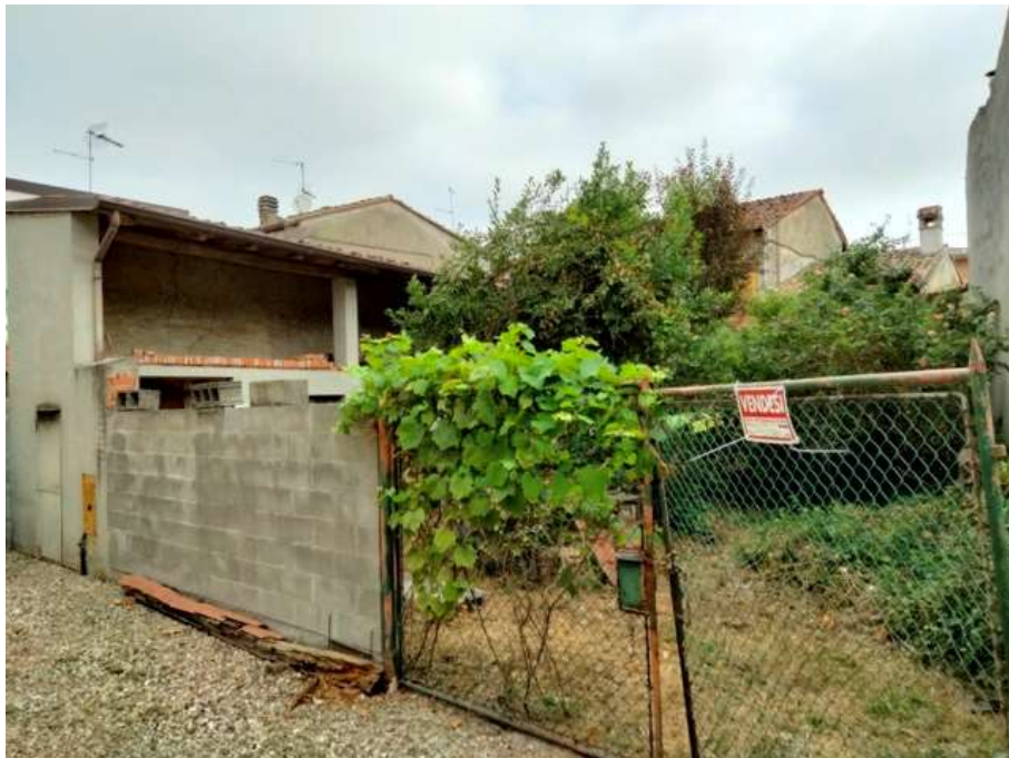
F2: Ingresso al compendio dallo stradello di proprietà
