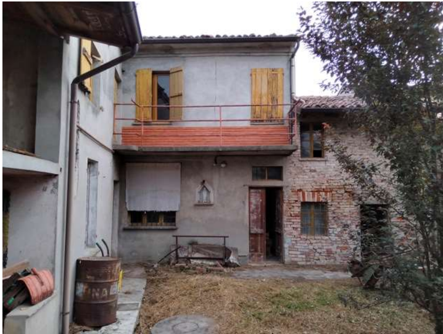
F5: - Prospetto sud/ovest – part. 180/3 e 749/4
