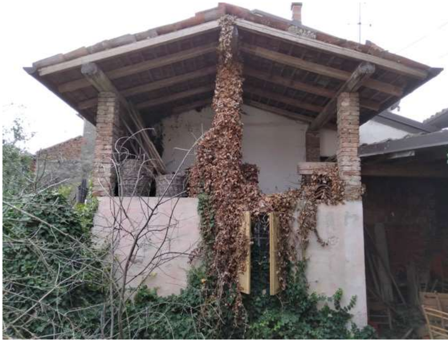
F20: Fabb.to di serv. sulla part. 749 (lato nord/est)
