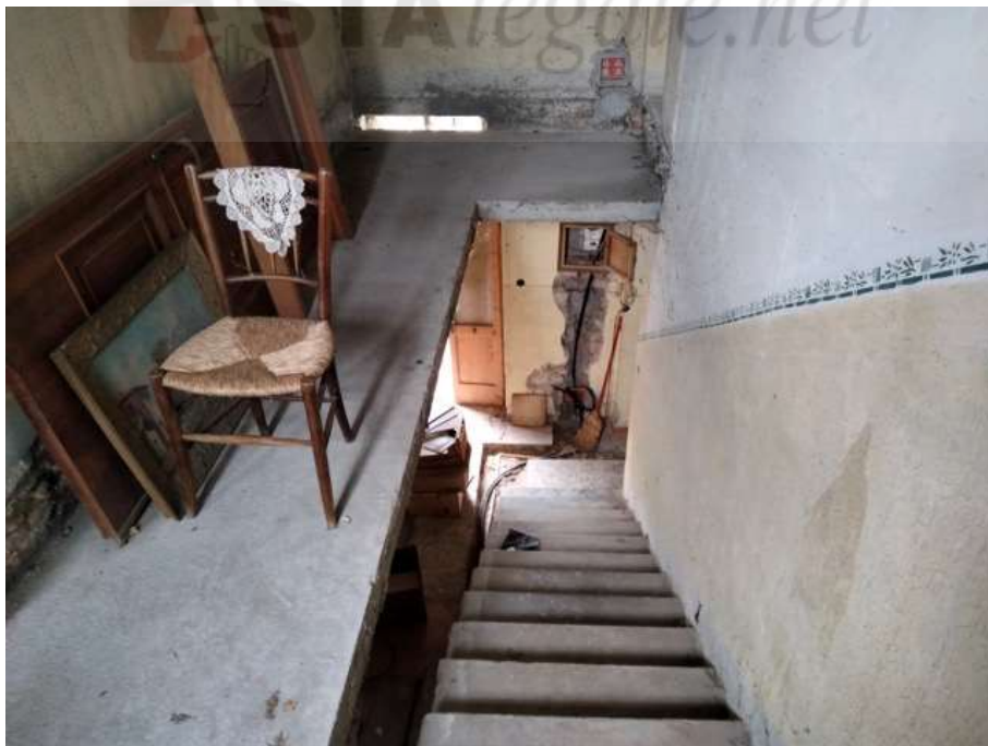
F10: Scala interna di collegamento ai piani (part. 180/3)
