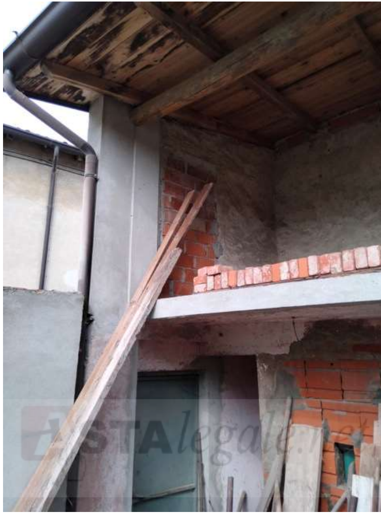
F19: Fabb.to di servizio - uscita sullo stradello
