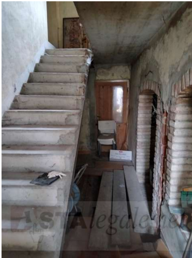
F11: Scala interna di collegamento ai piani (part. 180/3)
