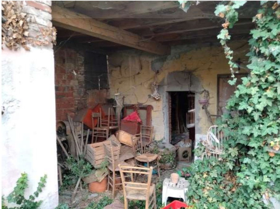
F21: tettoia colleg. alle partt. 749/4 e 180/3
