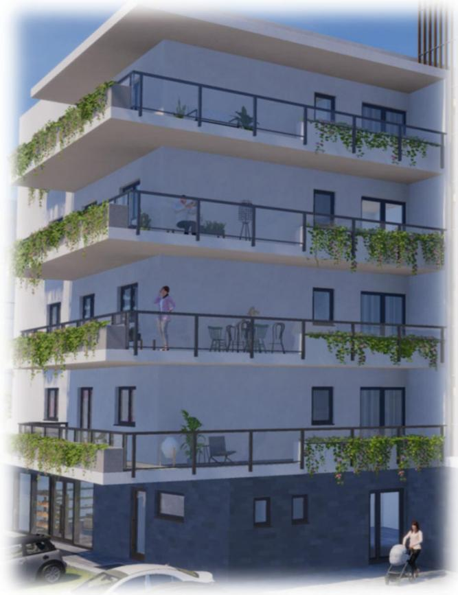
Inoltre presenteranno Fioriera per balcone realizzata con paretine in c a da cm 10 intonacata o a faccia vista dello spessore complessivo di cm 45 , paretine 10+10 vano utile terriccio 25 cm profondità 35 cm. Vano utile impermeabilizzato con membrana a freddo monocomponente in emulsione acquosa. Compreso di sistema di deflusso delle acque canalizzato nelle colonne di scarico dedicate.
