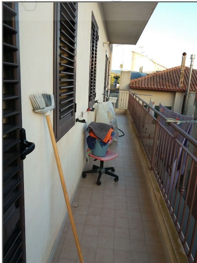
Foto 16: Balcone retro strada
