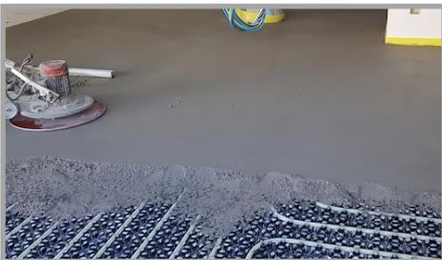
Il sottofondo di preparazione alla posa dei pavimenti a copertura delle tubazioni degli impianti, è previsto con massetto di cemento alleggerito isolante per uno spessore di circa 10cm e di sottofondo in sabbia e cemento con additivo apposito a copertura dell'impianto di riscaldamento a pannelli radianti in cls per uno spessore di 5/6 cm, con interposta rete elettrosaldata zincata 5mm
