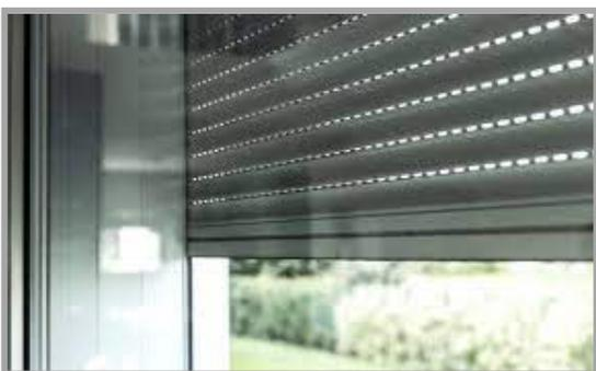
Tapparelle in acciaio coibentate, con colorazione grigia, MOTORIZZATE, direttamente nel MONOBLOCCO del falso telaio esterno. Celino in fibrocemento brandeggiante.
