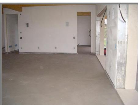
Tutte le pareti e i soffitti verranno intonacati con materiali idonei apposti per interno, con spessore di circa 1,5 - 2cm. Prima della relativa applicazione saranno posizionati, perfettamente allineati ed a piombo i profilati guida in lamiera zincata.
