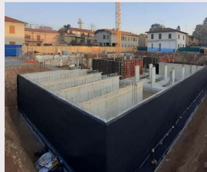
Figura 10 – Impermeabilizzazioni eseguite in altro cantiere
