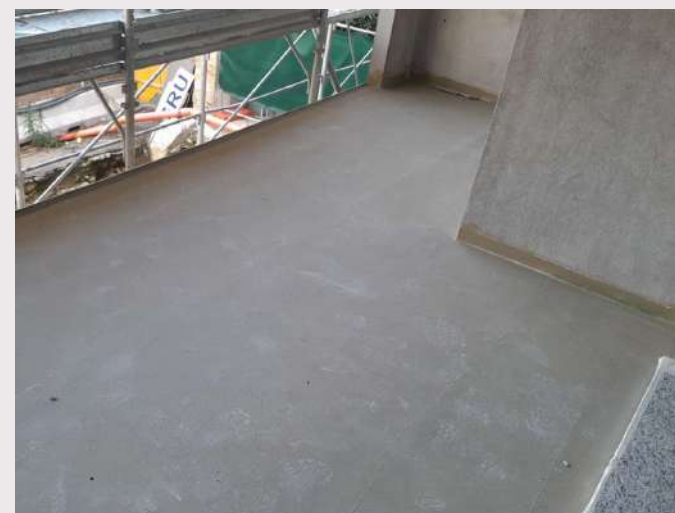
Figura 11 – Opere di impermeabilizzazione balcone eseguite in altro cantiere
