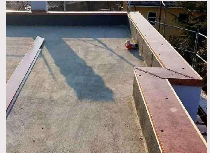
Figura 17 – Cappellotto in lattoneria coronamento copertura
