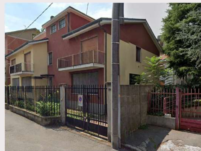
Figura 2 – Stato di fatto, vista stradale
