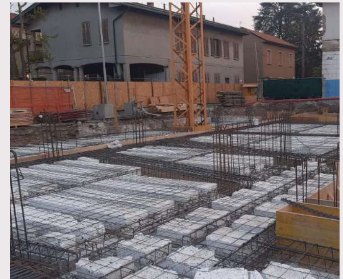
Figura 8 – Solaio predalles realizzato in altro cantiere
