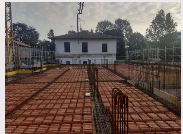
Figura 9 – Solaio laterocemento realizzato in altro cantiere
