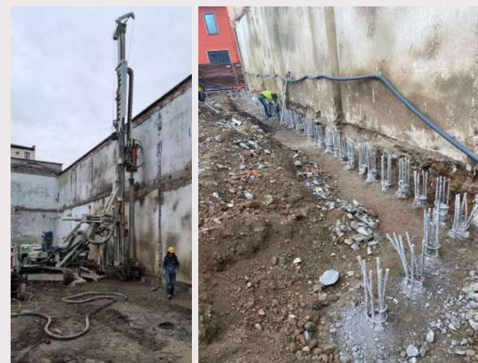
Figura 4 – Realizzazione berlinese in altro cantiere
