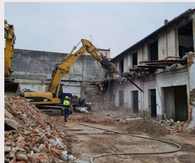
Figura 3 – Intervento di demolizione edificio eseguito in altro cantiere
