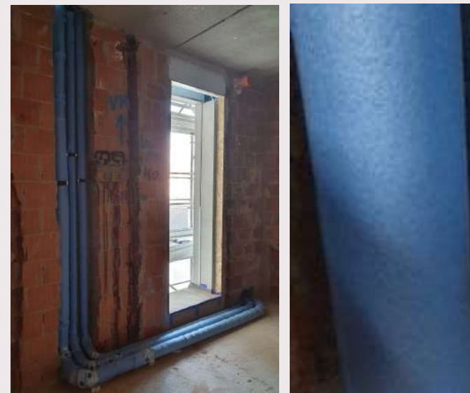
Figura 21 – Colonne montanti
