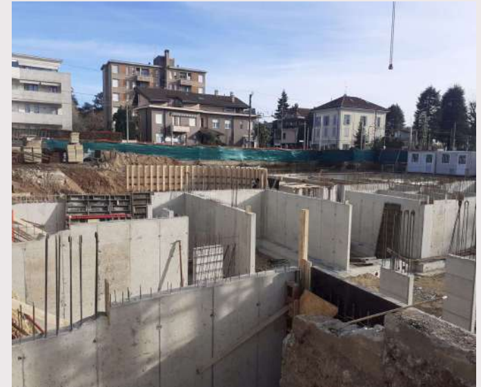
Figura 6 – Opere in C.A. eseguito in altro cantiere
