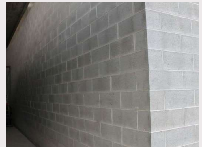
Figura 13 – Muratura blocchi faccia a vista
