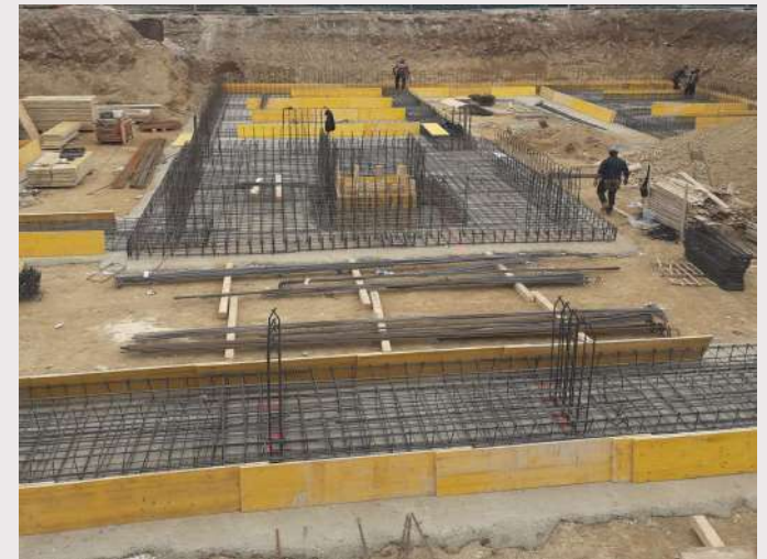
Figura 7 – Opere in C.A. eseguito in altro cantiere
