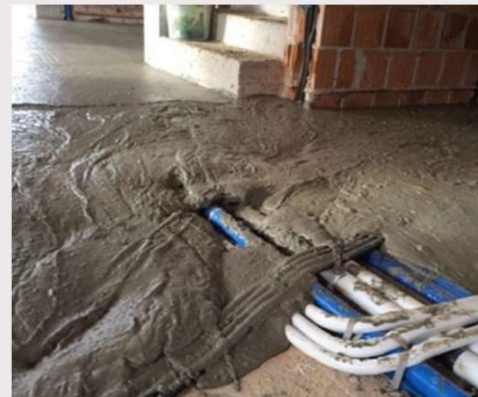
Figura 22 – Sottofondo alleggerito
