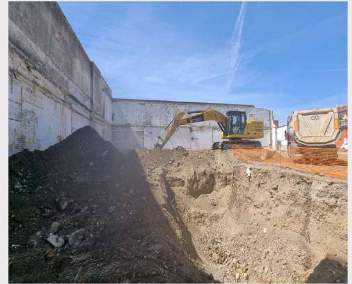
Figura 5 – Scavi eseguiti in altro cantiere
