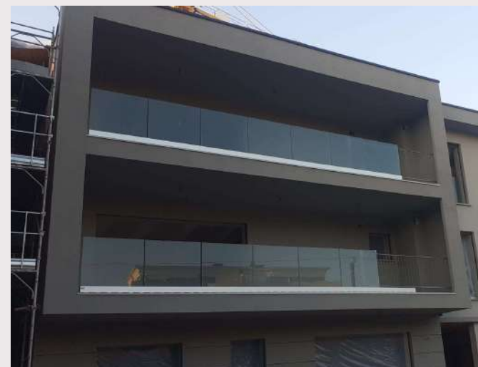
Figura 33 – Parapetti vetrati realizzati in altro cantiere
