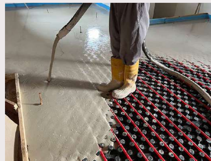
Figura 23 – Massetto radiante
