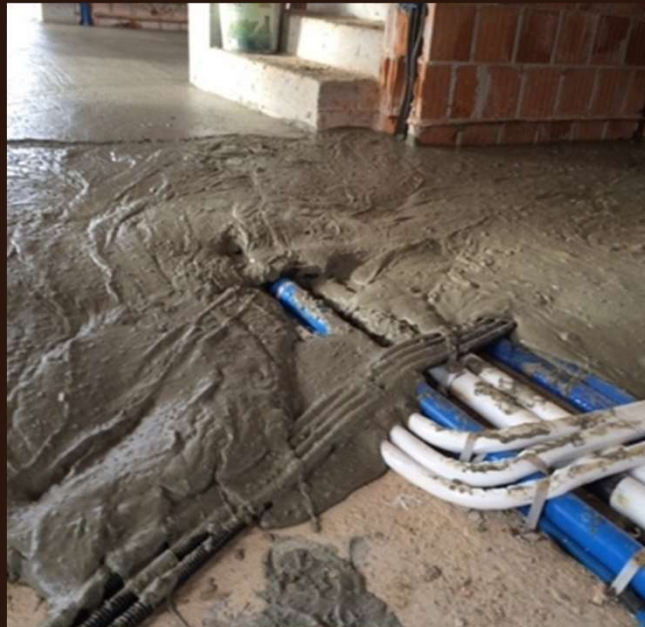
Figura 9 – esecuzione sottofondo alleggerito
