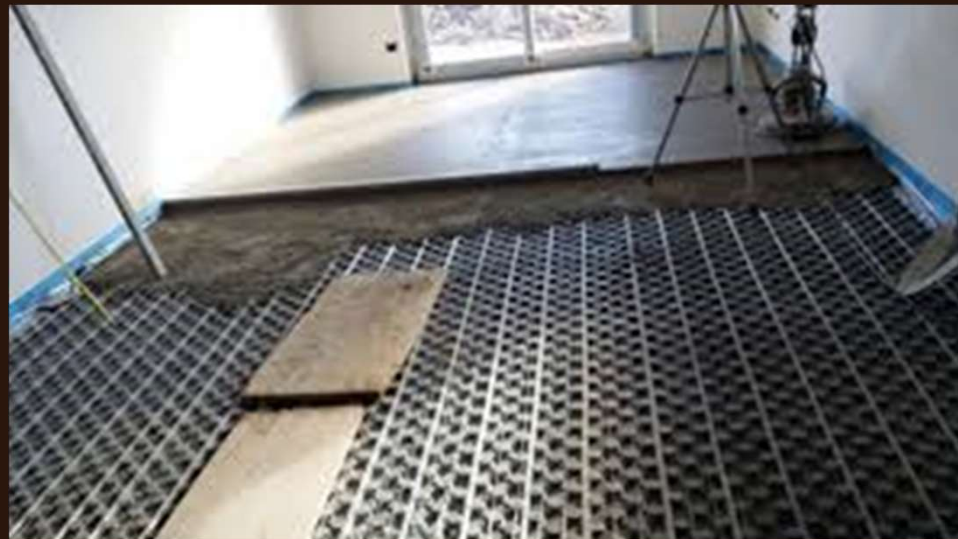
Figura 10 – esecuzione massetto radiante
