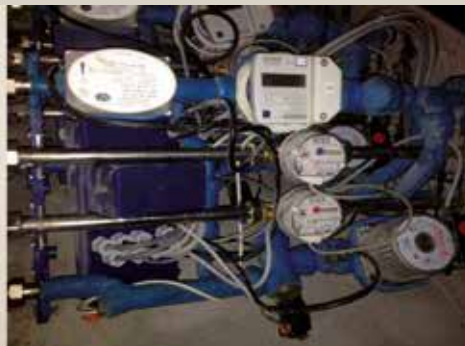
Collettore pannelli radianti utilizzati sia per l'impianto di riscaldamento che raffrescamento
