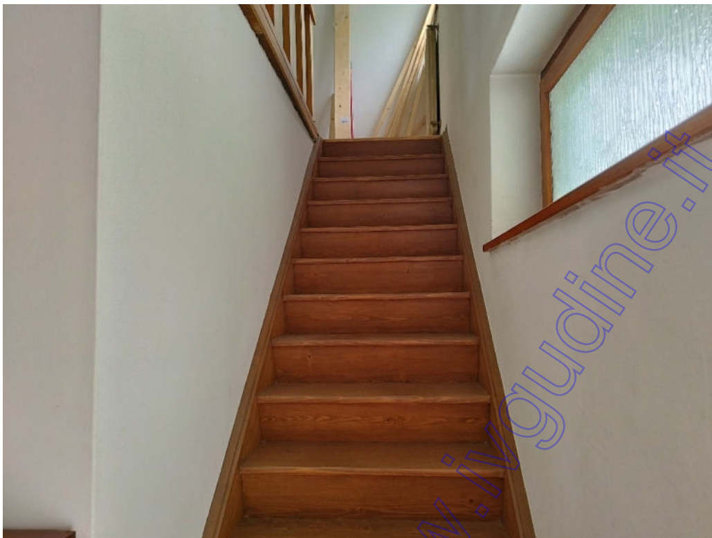
particolare vano scale accesso piano primo
