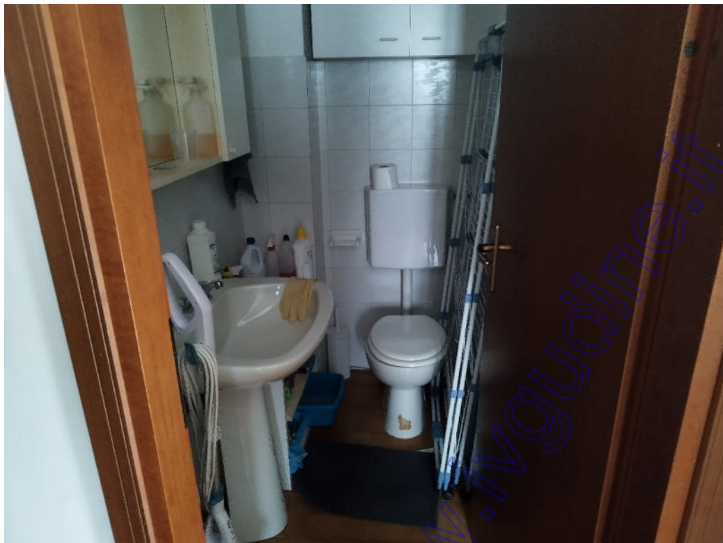
particolare ripostiglio trasformato (senza titolo edilizio) in servizio igienico
