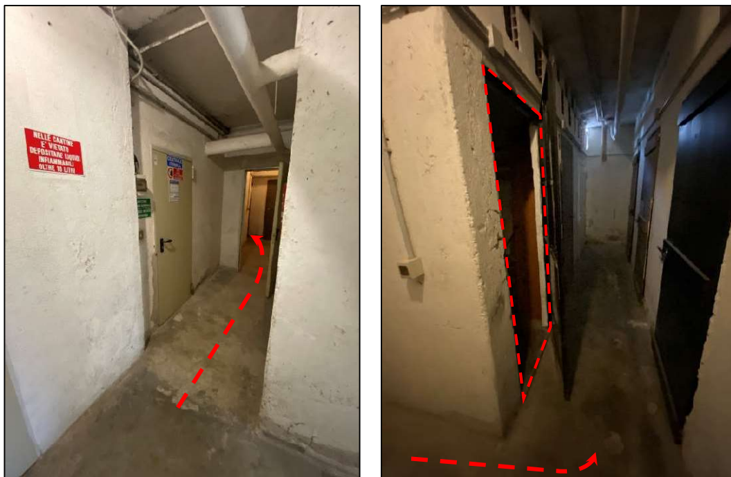
Foto n°18 e 19 – Corridoio di accesso alla cantina (a tergo della centrale termica)
