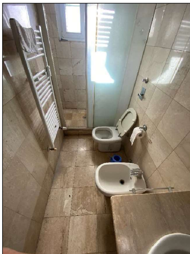
Foto n°17 – Bagno (dettaglio della pavimentazione e dei rivestimenti)
