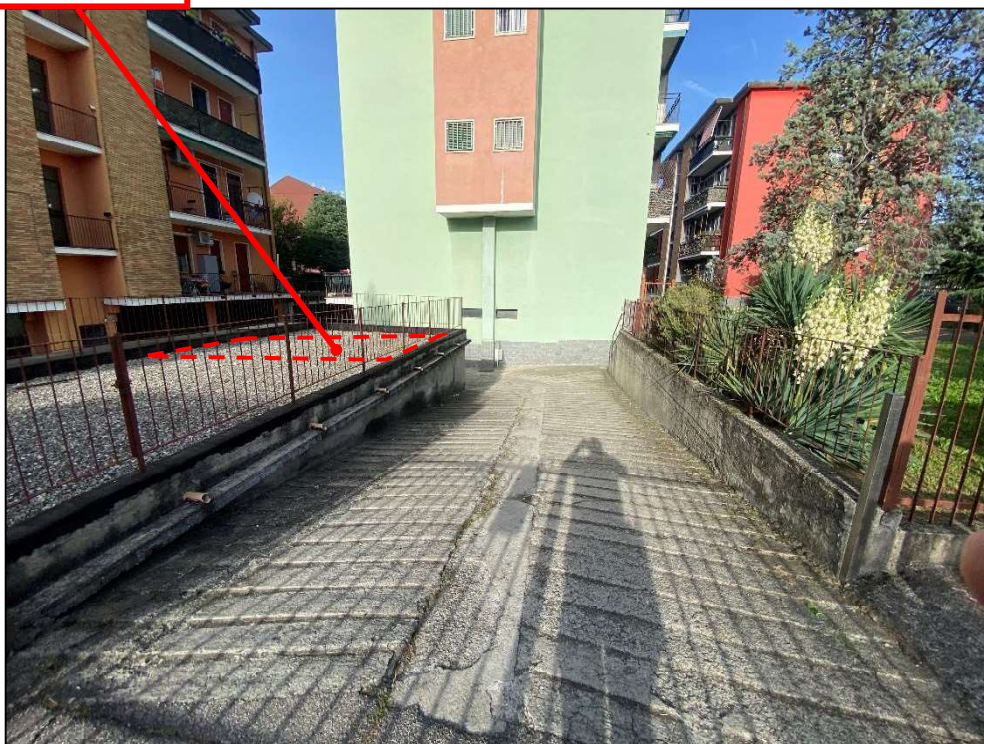
Foto n°21 – Rampa di accesso ai box auto dalla Via Mameli
