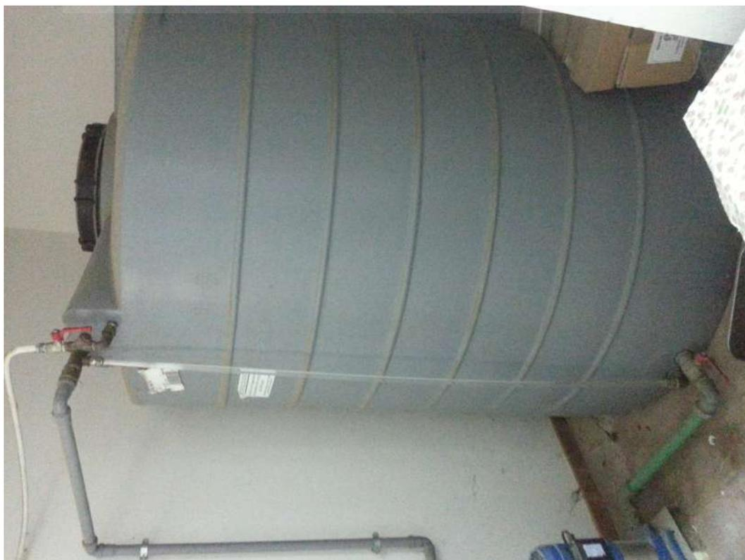
Foto n. 18 – Serbatoio di riserva acqua di litri 3000.
