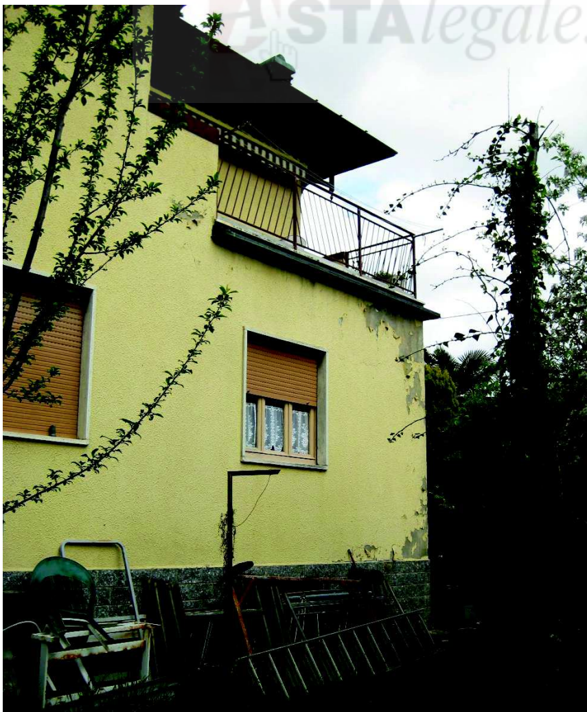
Vista fronte sud-ovest
