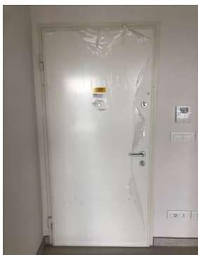
Pannello interno liscio di colore bianco ed esterno liscio di colore a scelta della D.L., maniglia in alluminio cromo-satinato. Dimensioni cm. 90x210 in opera su telaio in lamiera della ditta COCIF o similare a scelta della D.L.
