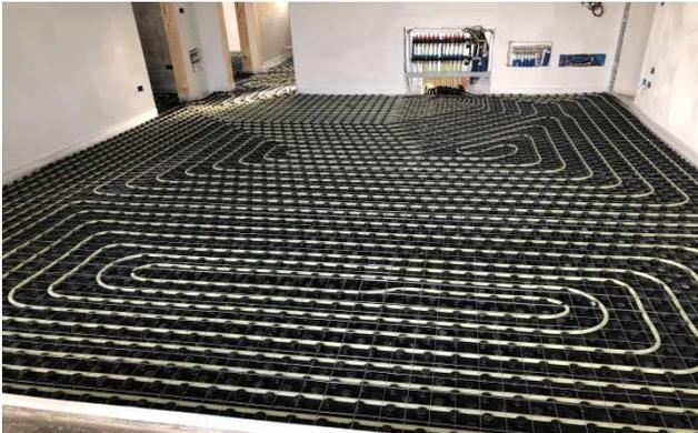
Realizzato con pannelli radianti a pavimento marca EMMETI o similari in tutto l'alloggio; nei bagni, in aggiunta ai pannelli radianti, è prevista la fornitura e posa di un termo arredo in acciaio tipo IRSAPNOVO cm. 120x50 o similari
