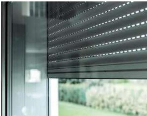
Gli avvolgibili saranno in alluminio coibentato con poliuretano di colore chiaro e dotati di manovra elettrica a motore. Tutti gli infissi ad anta a battente saranno dotati di apertura vasistas, ferramenta e accessori di colore bianco.
