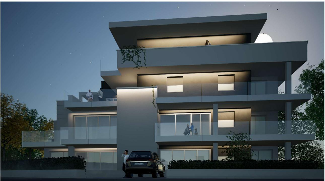
termico isolante, i solai realizzati in latero cemento e le tramezzature interne in laterizio forato. La copertura, piana, servirà ad accogliere i pannelli fotovoltaici.
