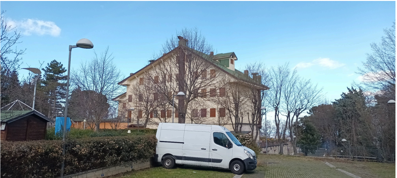
Vista fabbricato facciata Sud
