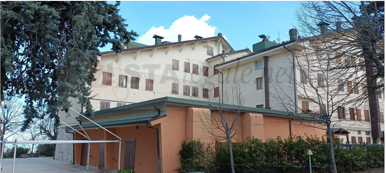
Vista fabbricato spigolo Sud-Ovest
