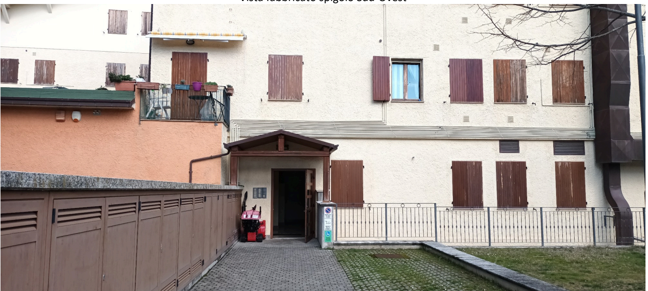
Ingresso vano scala
