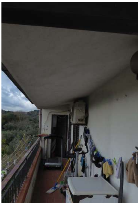
Foto Esterno 21. Fg 29 P.Ila 276 Sub 12
