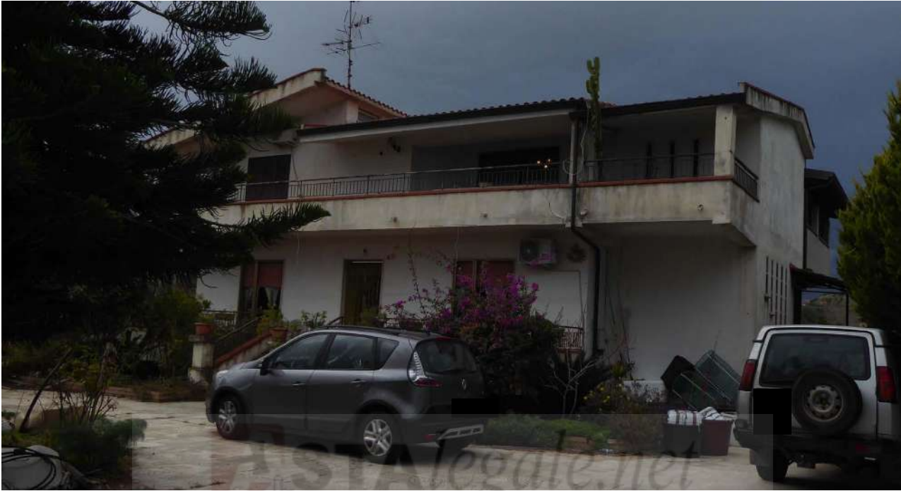
Foto Esterno 1. Fg 29 P.IIa 276 (Maggior fabbricato)
