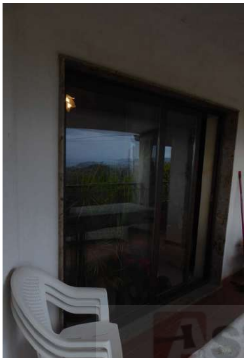
Foto Esterno 19. Fg 29 P.Ila 276 Sub 12
