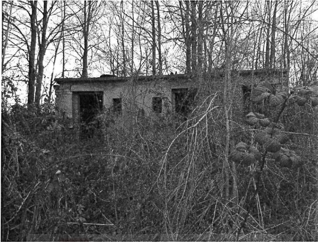
FOTO 09 – Fabbricato accessorio part. 34
