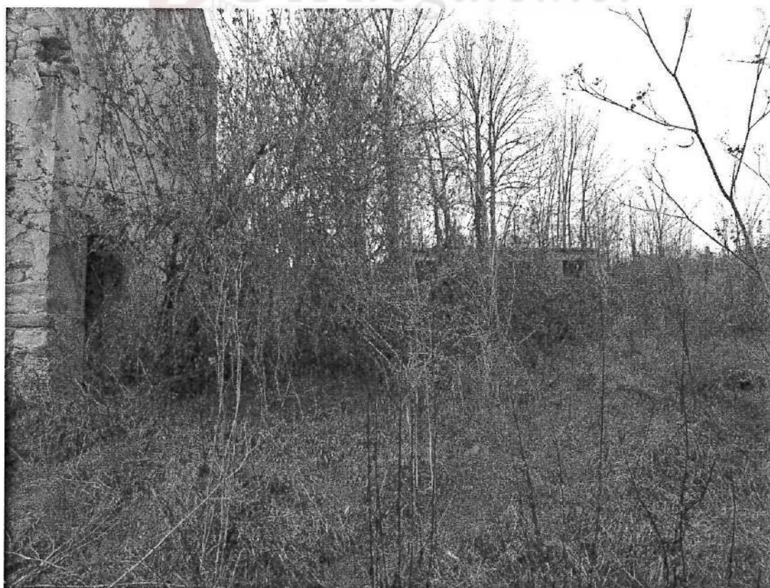
FOTO 08 – Fabbricato principale – accessorio part. 34
