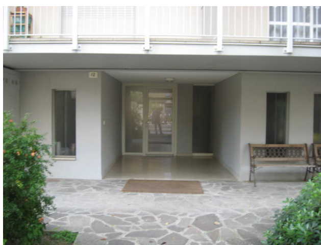
Ingresso comune e prospetto posteriore
